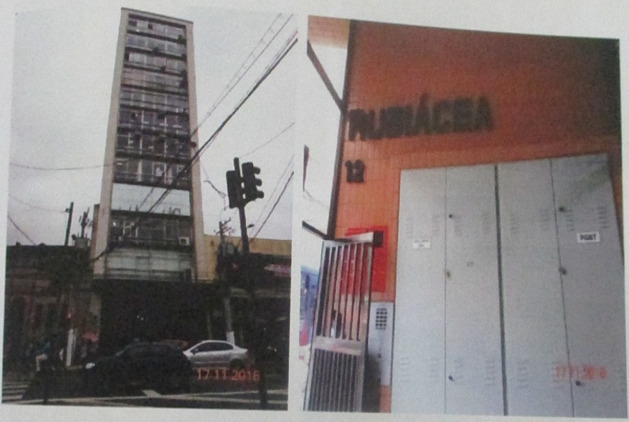
Vistas da fachada do Edifício Rubiácea e do hall de entrada, onde se localiza o imóvel avaliando.
