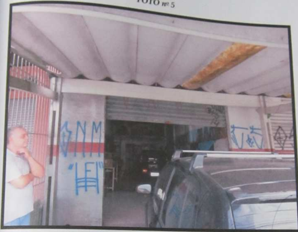
Vista da entrada estabelecimento comercial 1.
