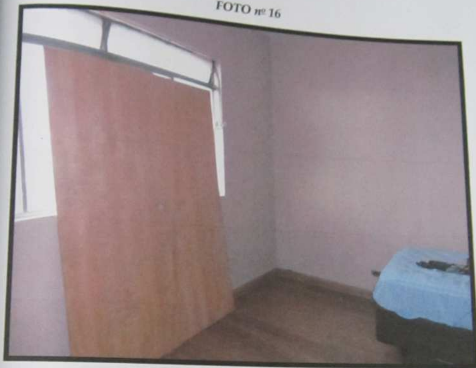
Vista do dormitório da unidade avalianda.
