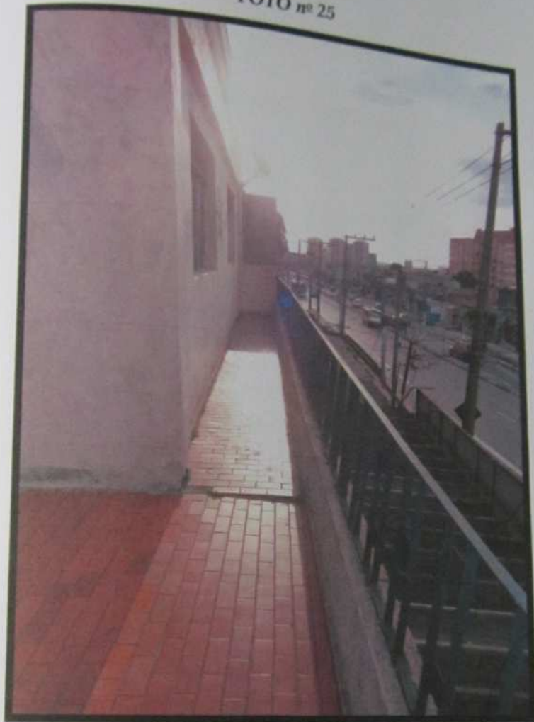
Vista frontal da unidade avalianda.
