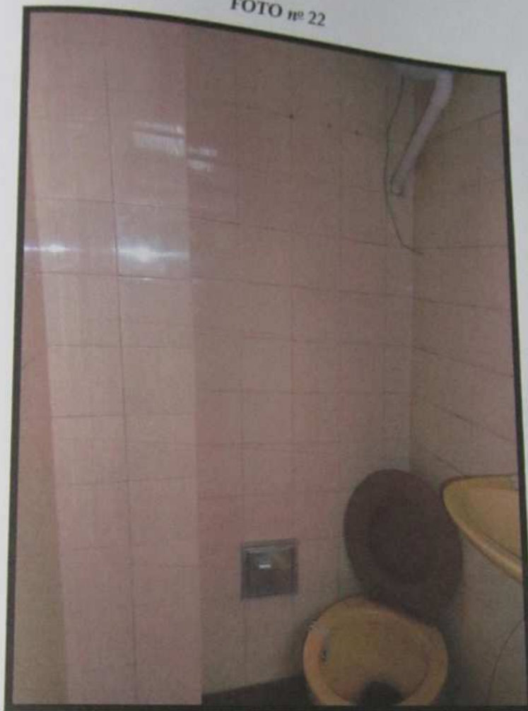
Vista do banheiro externo da unidade avaliada.
