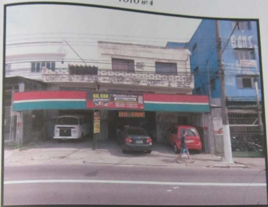
Outra vista frontal do imóvel avaliando.
