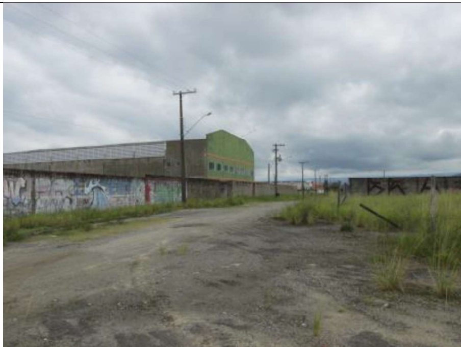
FOTO 02:- Vista do logradouro Rua Valdomiro do Espírito Santo esquina Rua Desembargador José Mauro Bourreat Ribeiro .
