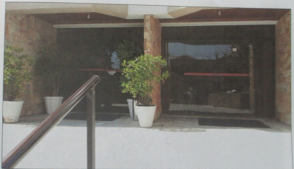
Figura 3 - Acesso ao interior do Edifício Maison Gledson
