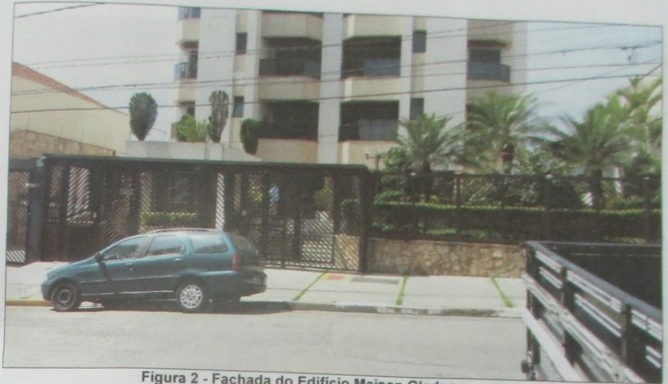
Figura 2 - Fachada do Edifício Maison Gledson
