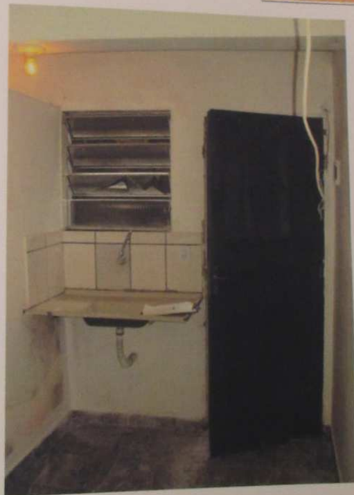
VISTA DA COZINHA.
