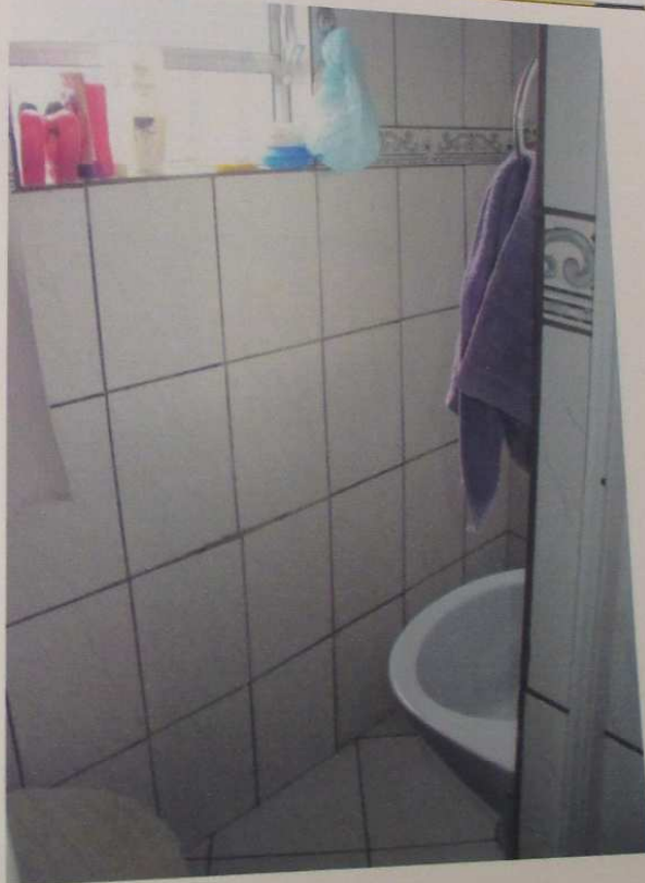
VISTA DO BANHEIRO DO SEGUNDO DORMITÓRIO.
