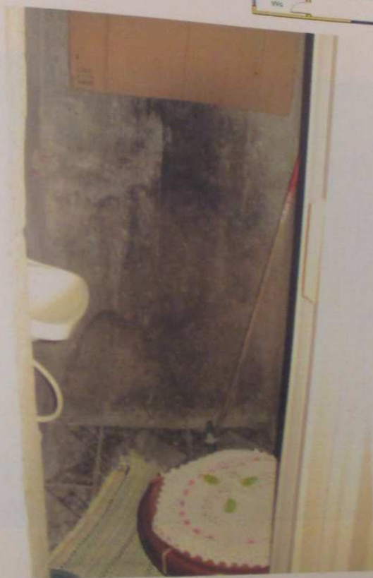
VISTA DO BANHEIRO DO PRIMEIRO DORMITÓRIO.
