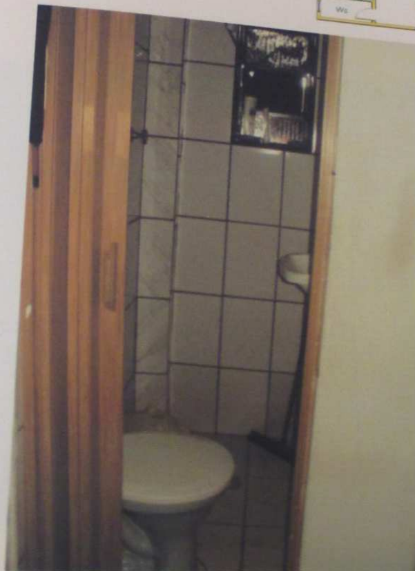
VISTA DO BANHEIRO DO DORMITÓRIO.
