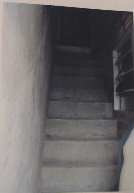
VISTA DA ESCADA DE ACESSO AO PAVIMENTO SUPERIOR.
