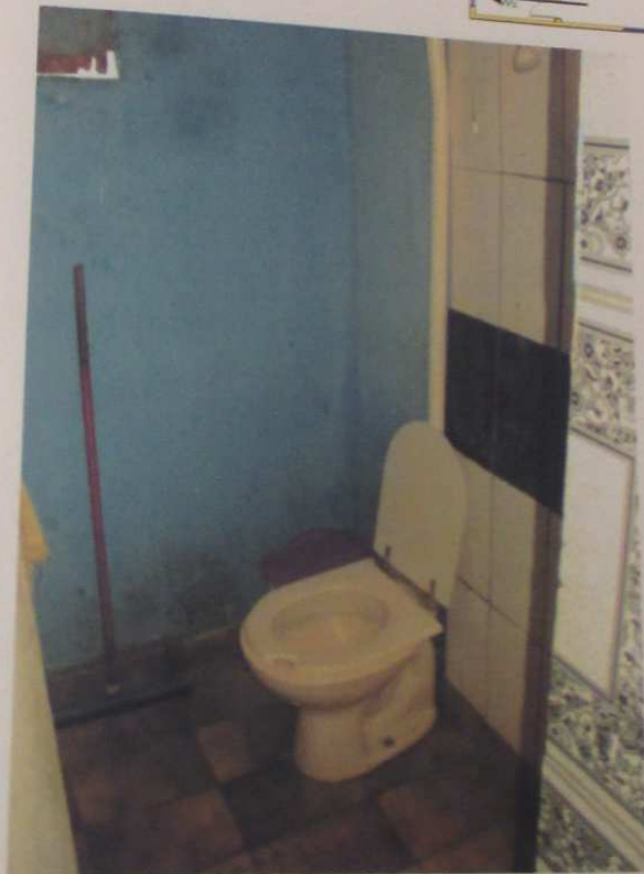
VISTA DO BANHEIRO DO DORMITÓRIO.
