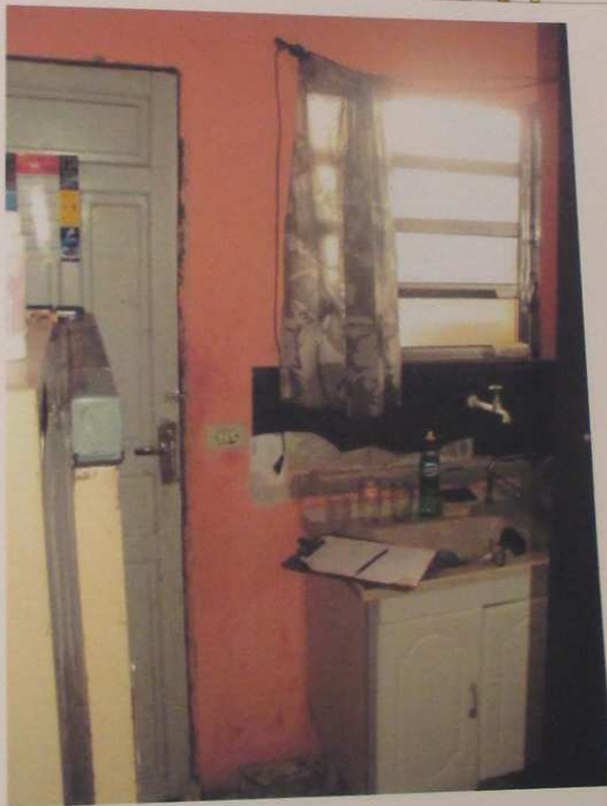
VISTA DO DORMITÓRIO/COZINHA.
