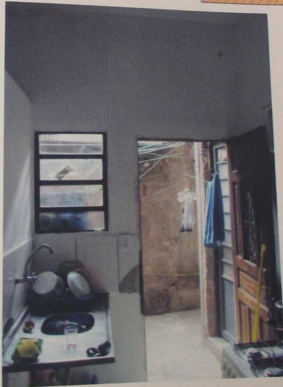
VISTA DA COZINHA.
