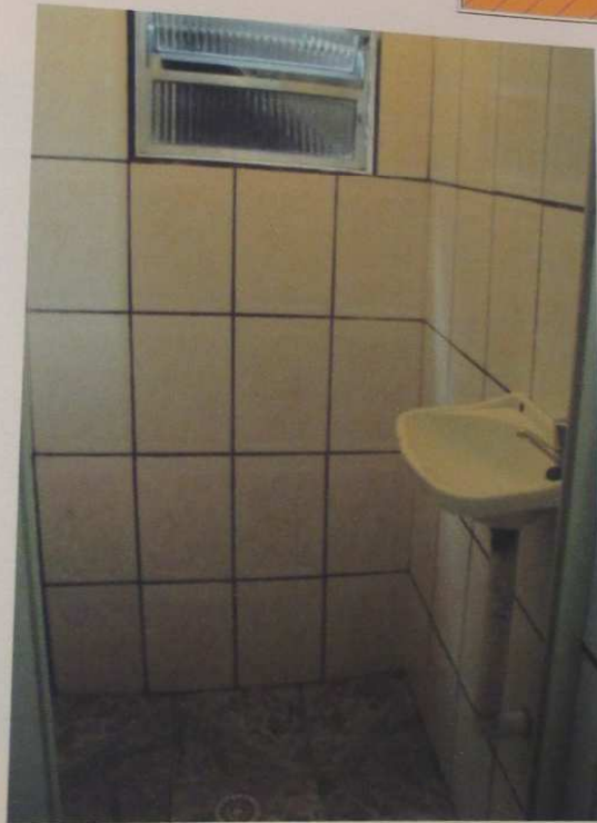
VISTA DO BANHEIRO.
