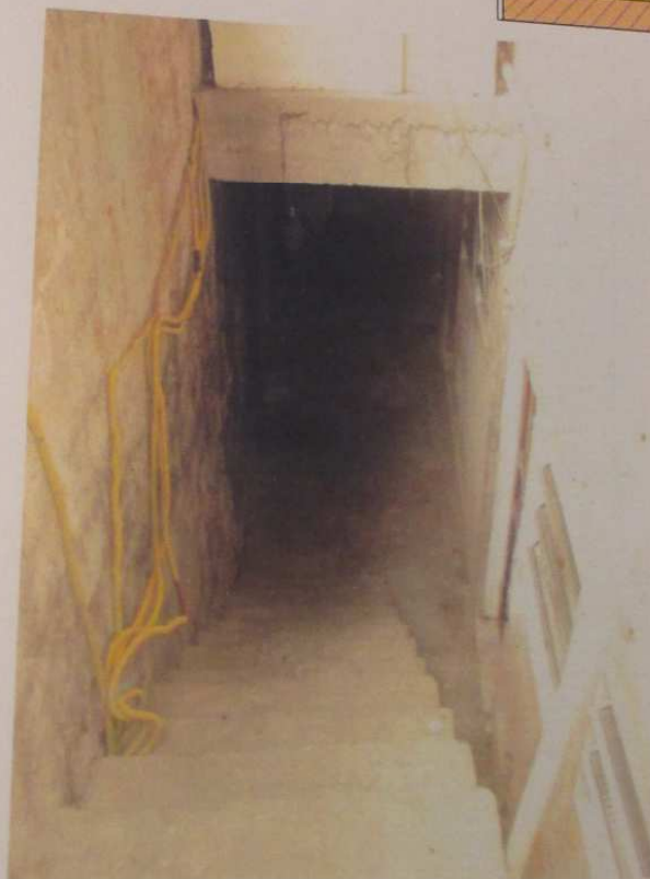
VISTA DA ESCADA DE ACESSO PARA O SEGUNDO PAVIMENTO INFERIOR.
