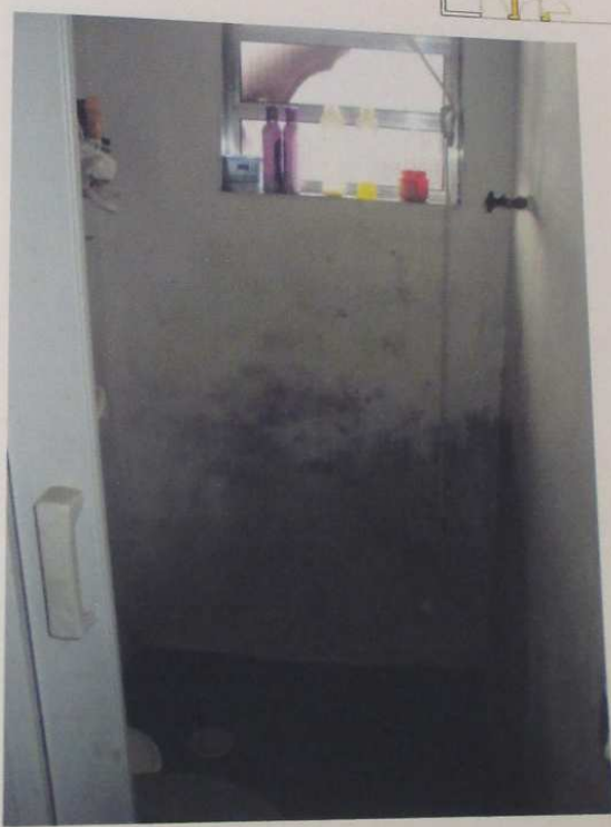
VISTA DO BANHEIRO.
