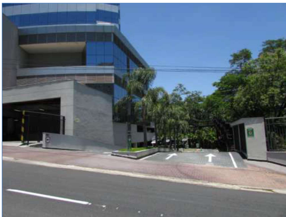
ENTRADA DE PEDESTRES E DE VEÍCULOS.
