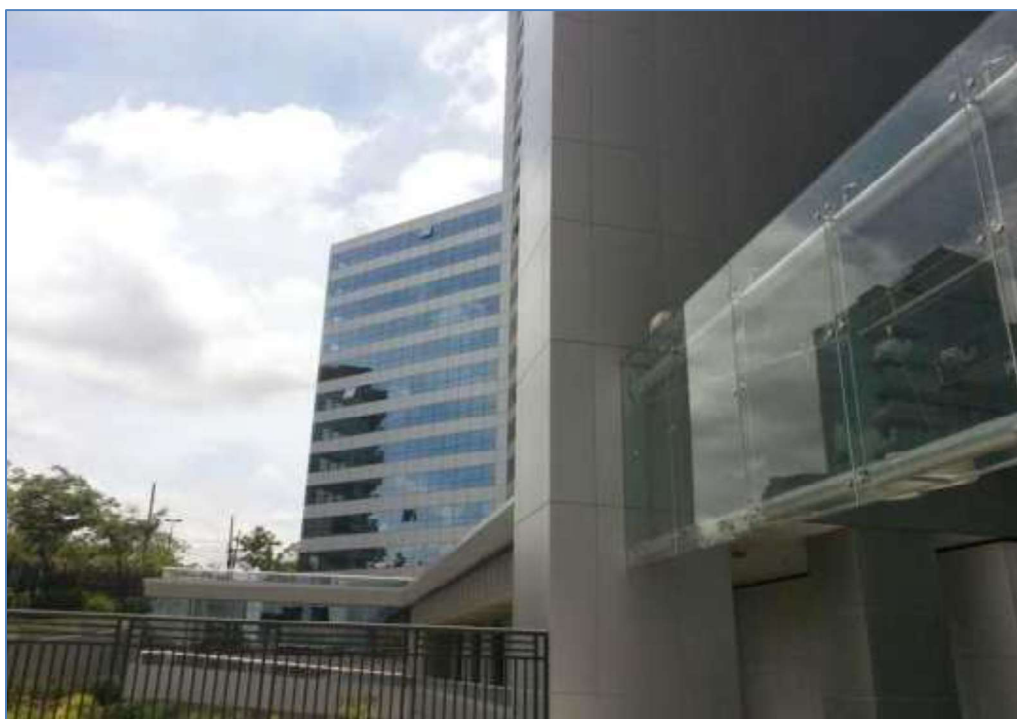
VISTA DO EMPREENDIMENTO.
