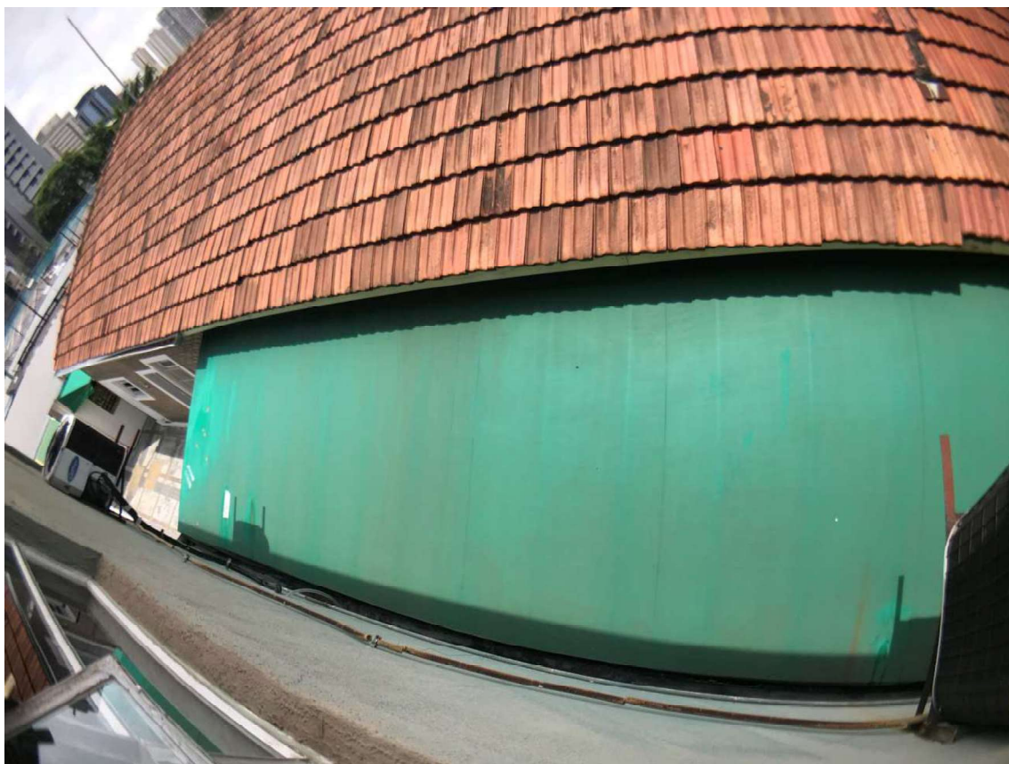
FOTO 34: Vista da cobertura do corredor central e do telhado da casa 02.
