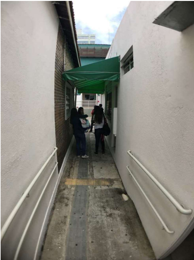
FOTO 22: Vista corredor externo.
