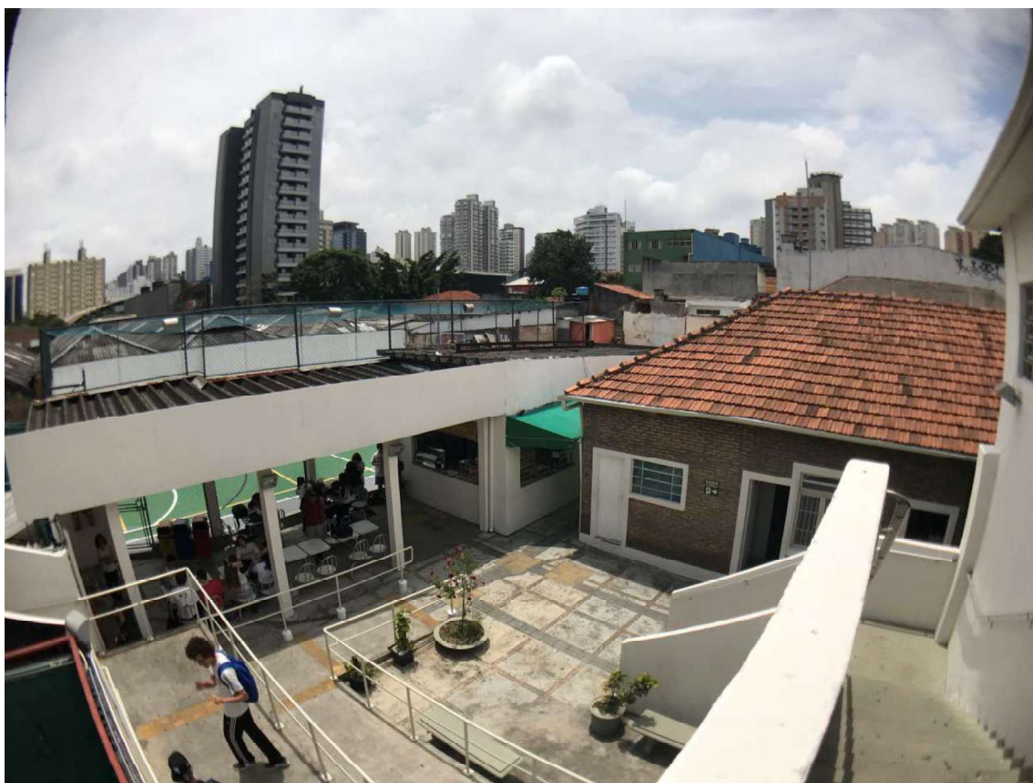
FOTO 30: Vista geral desde o pavimento superior.
