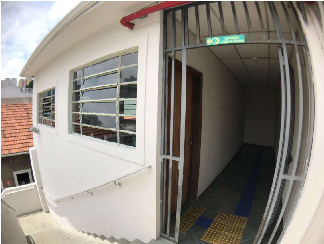
FOTO 32: Vista do corredor no pavimento superior.
