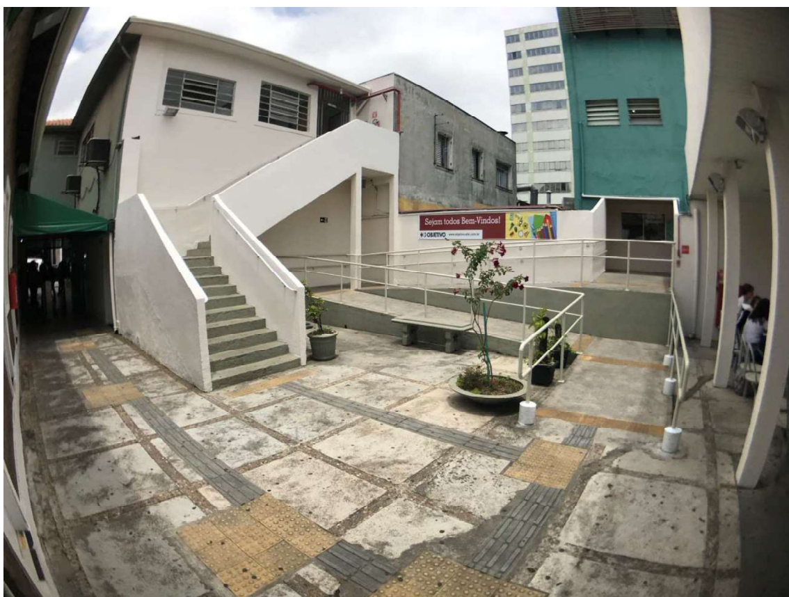
FOTO 26: Vista do pátio.
