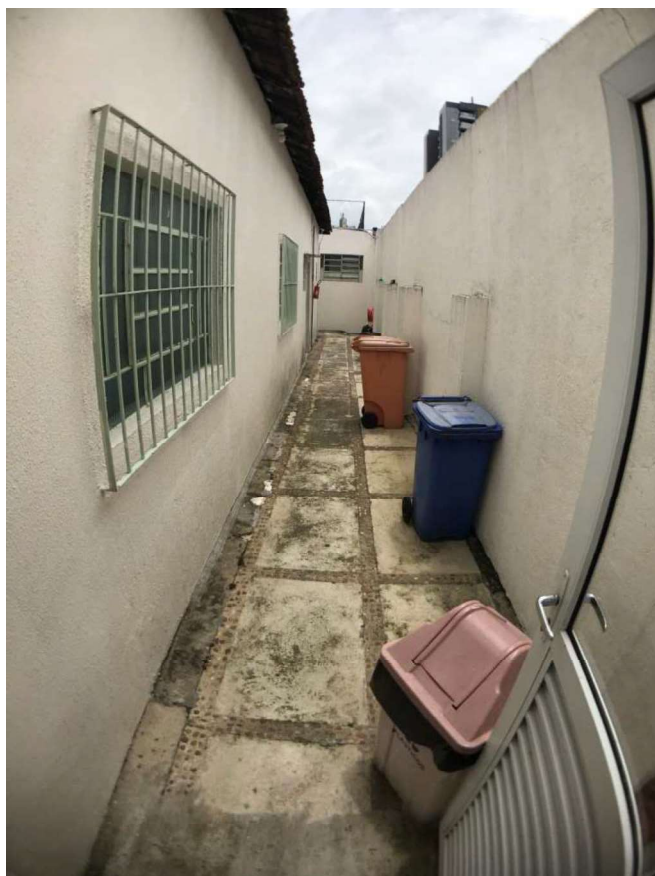
FOTO 20: Vista corredor lateral.
