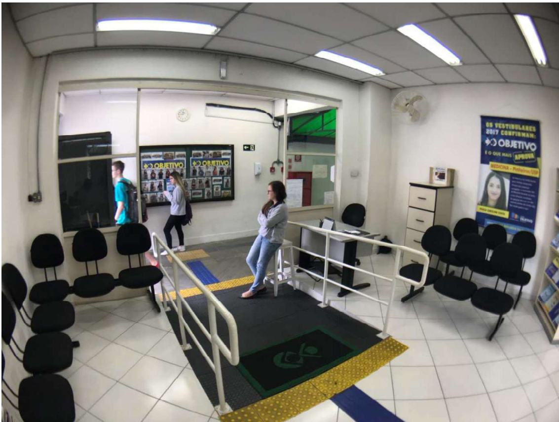
FOTO 06: Vista sala de espera.
