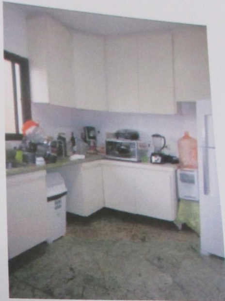
Fotos 44/45 – Vistas da cozinha, notando-se o piso em granito, bancada/pia tb em granito, azulejos até o teto, caixilhos de alumínio anodizado preto, armários em fórmica.
