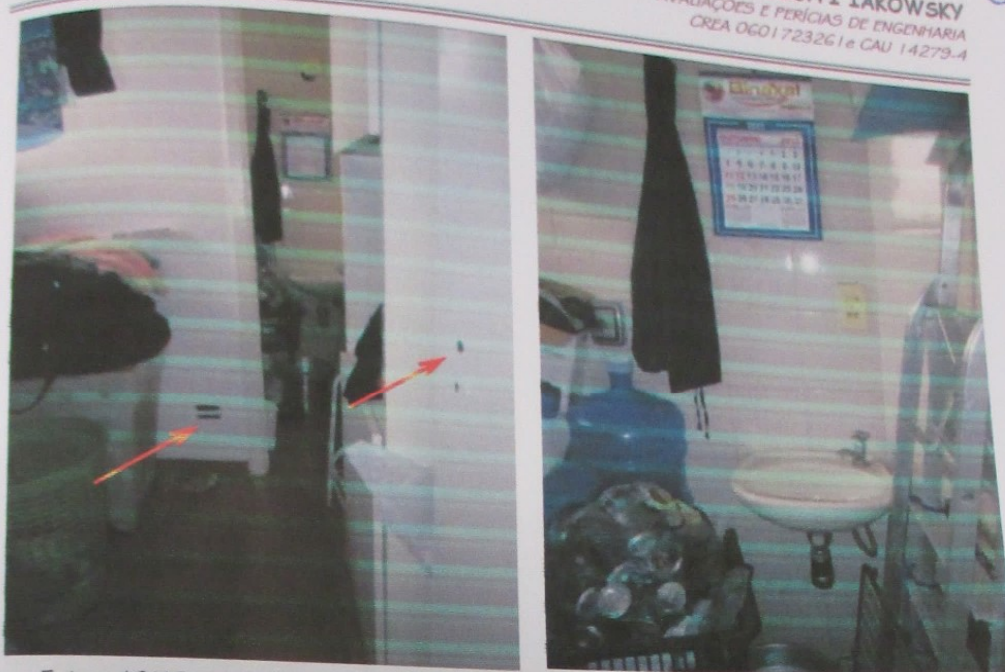
Fotos 48/49 – A suíte para empregada, notando-se o dormitório e seu banheiro privativo. Destaque para a falta da maçaneta/fechadura e do acabamento da tomada (espelho).
