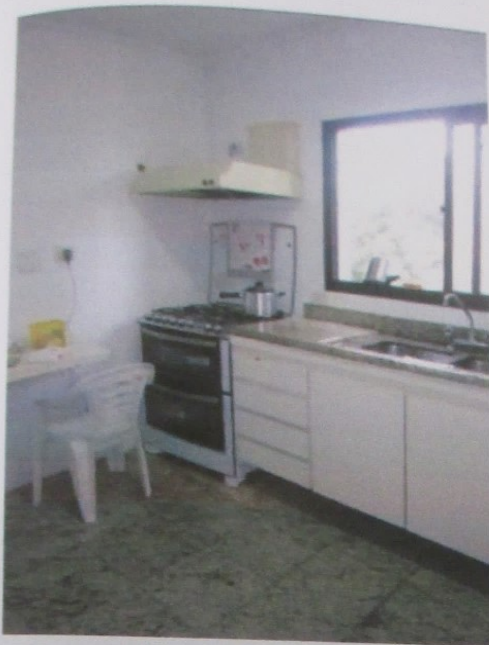
Fotos 44/45 – Vistas da cozinha, notando-se o piso em granito, bancada/pia tb em granito, azulejos até o teto, caixilhos de alumínio anodizado preto, armários em fórmica.
