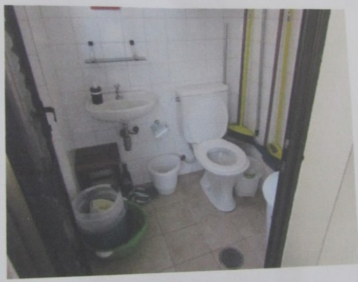
Foto 22 - Vista do WC na área de serviço do imóvel avaliando.
