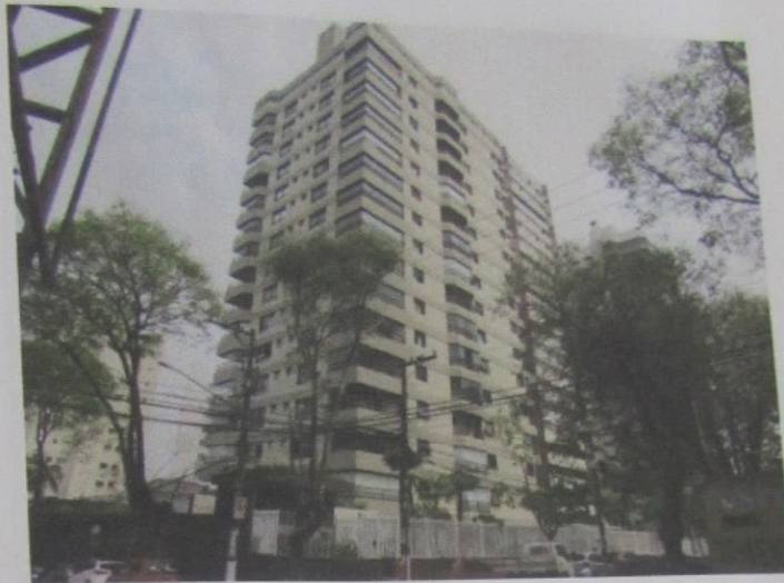
Foto 03 – Vista da fachada do imóvel em questão.
