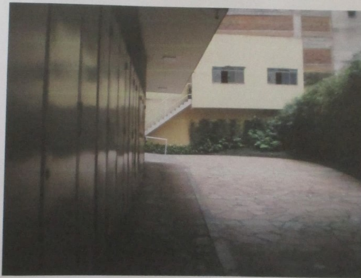
Foto 2- Vista entrando no pátio interno do prédio
