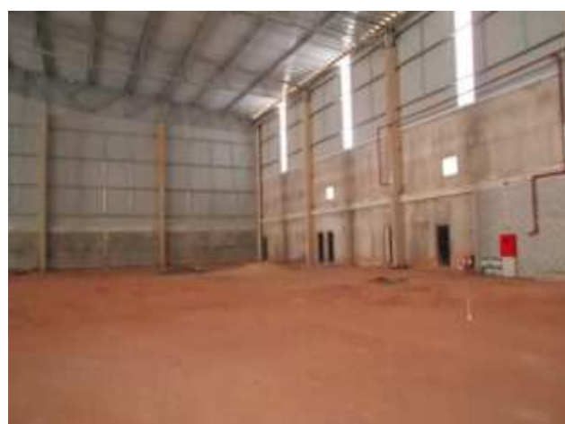
Características Internas do Imóvel Avaliando.
