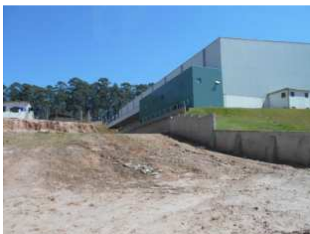
Características Gerais do Imóvel Avaliando.
