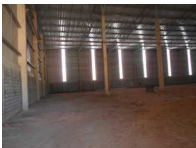
Características Internas do Imóvel Avaliando.
