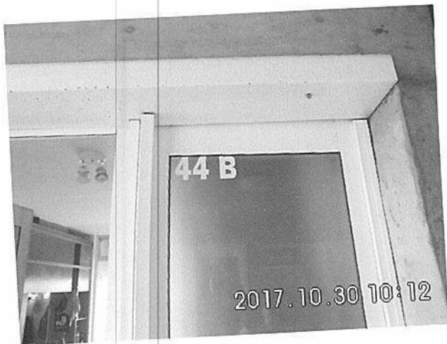
Entrada unidade 44 B
