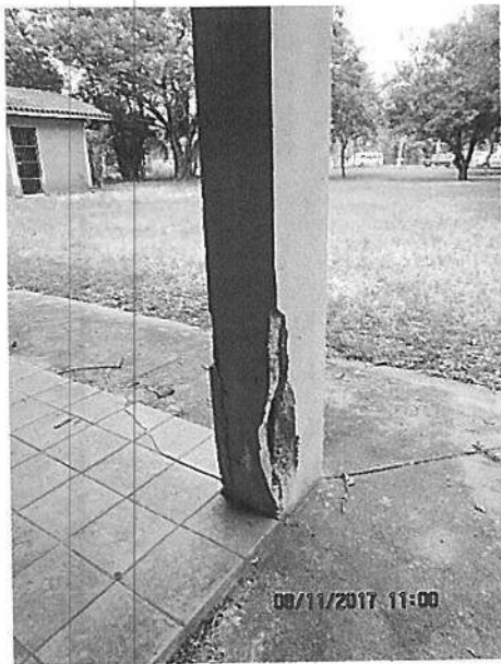
Detalhe coluna com fissura e ferragem exposta
