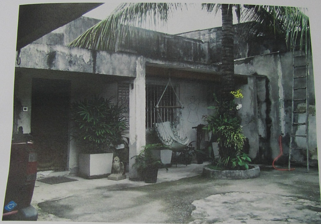
FOTO 3: FACHADA DO IMÓVEL.
