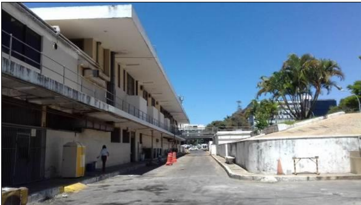
ACESSO À ENTRADA DE SERVIÇO
