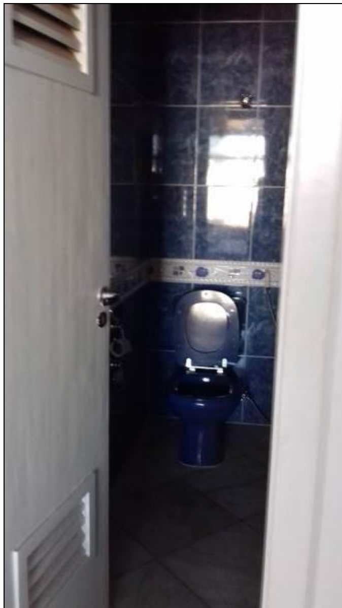
SALÃO DE CONVENÇÕES - BANHEIRO
