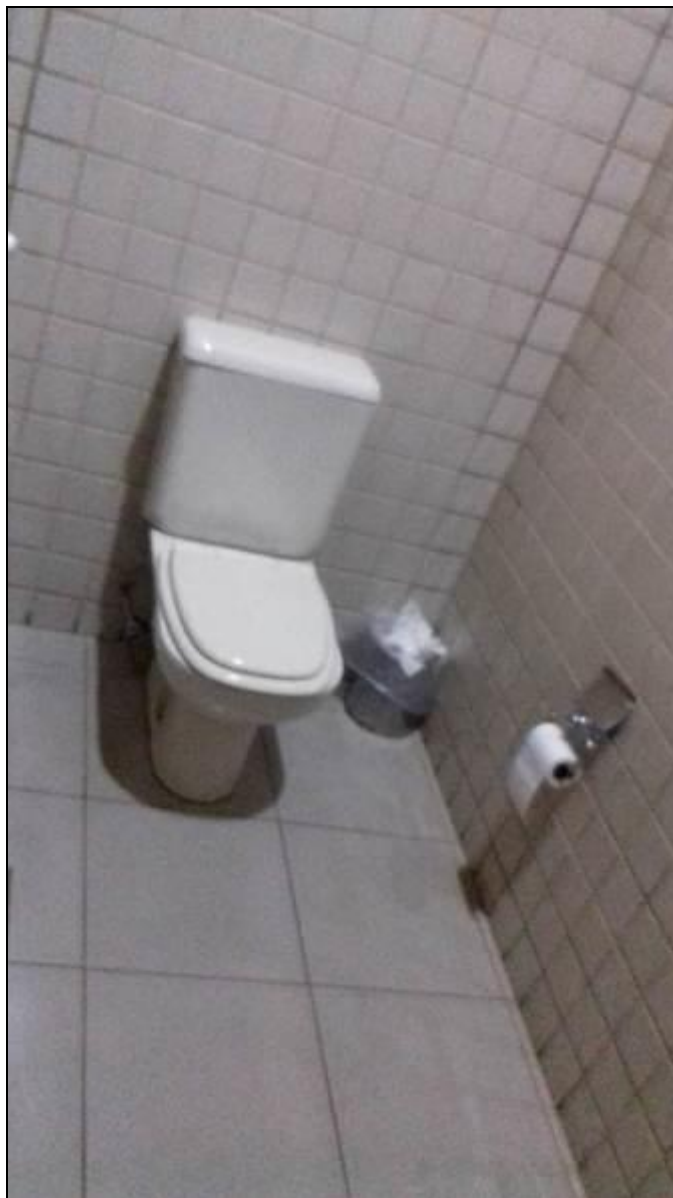
SANITÁRIO DA SAUNA
