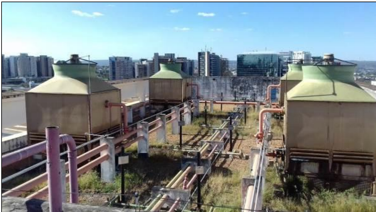
COBERTURA DO HOTEL
