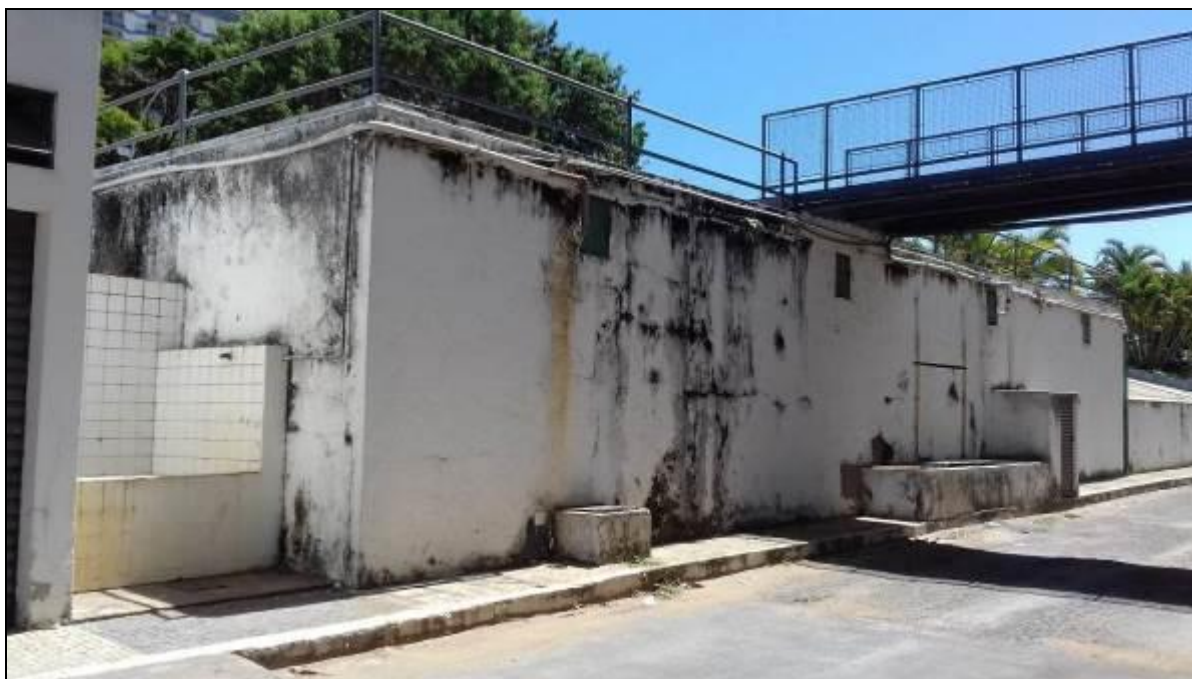
RESERVATÓRIO DE ÁGUA
