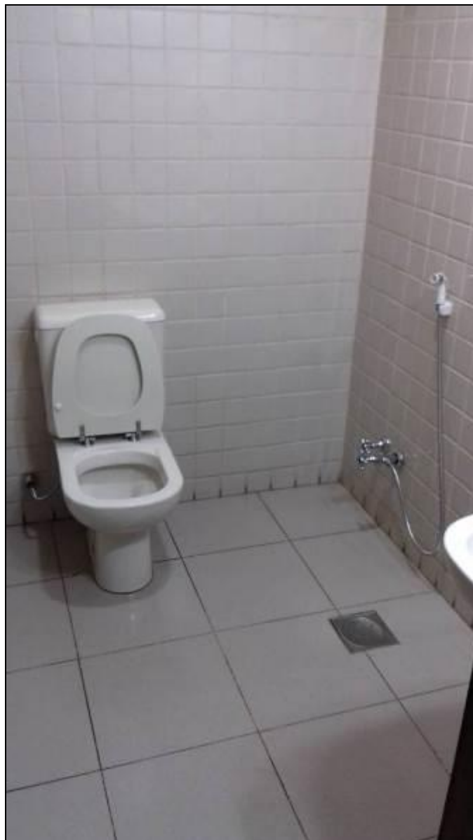
SANITÁRIO NO SUBSOLO
