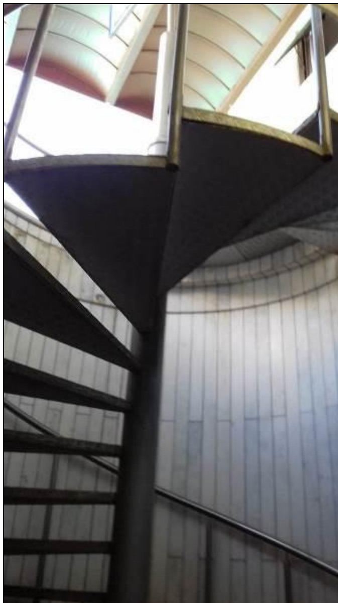
ESCADA DE ACESSO PARA SAUNA
