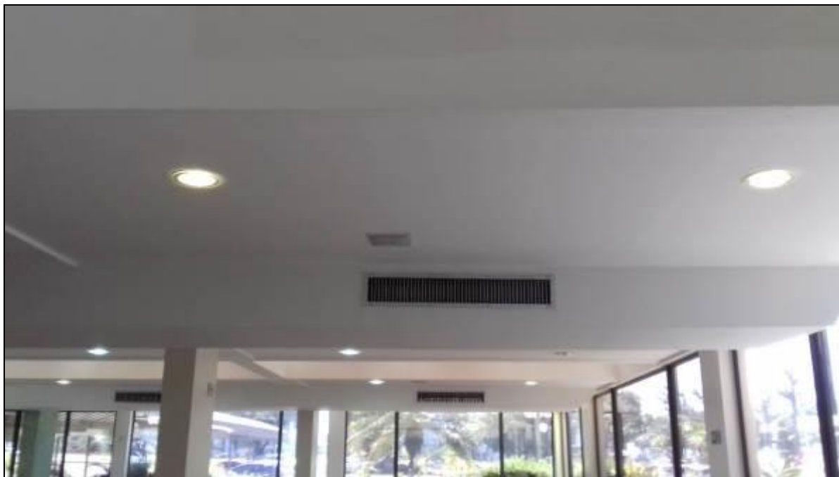
FORRO DO RESTAURANTE "TABOO GRILL" COM SAÍDAS DE AR CONDICIONADO CENTRAL
