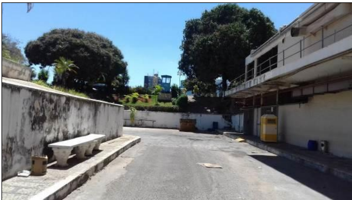
ACESSO À ENTRADA DE SERVIÇO
