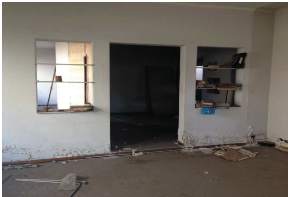
Aspecto de uma das Dependências da Edificação
