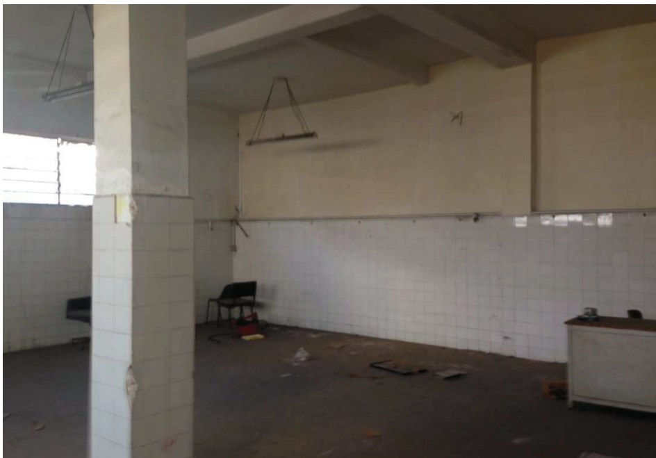
Aspecto de uma das Dependências da Edificação
