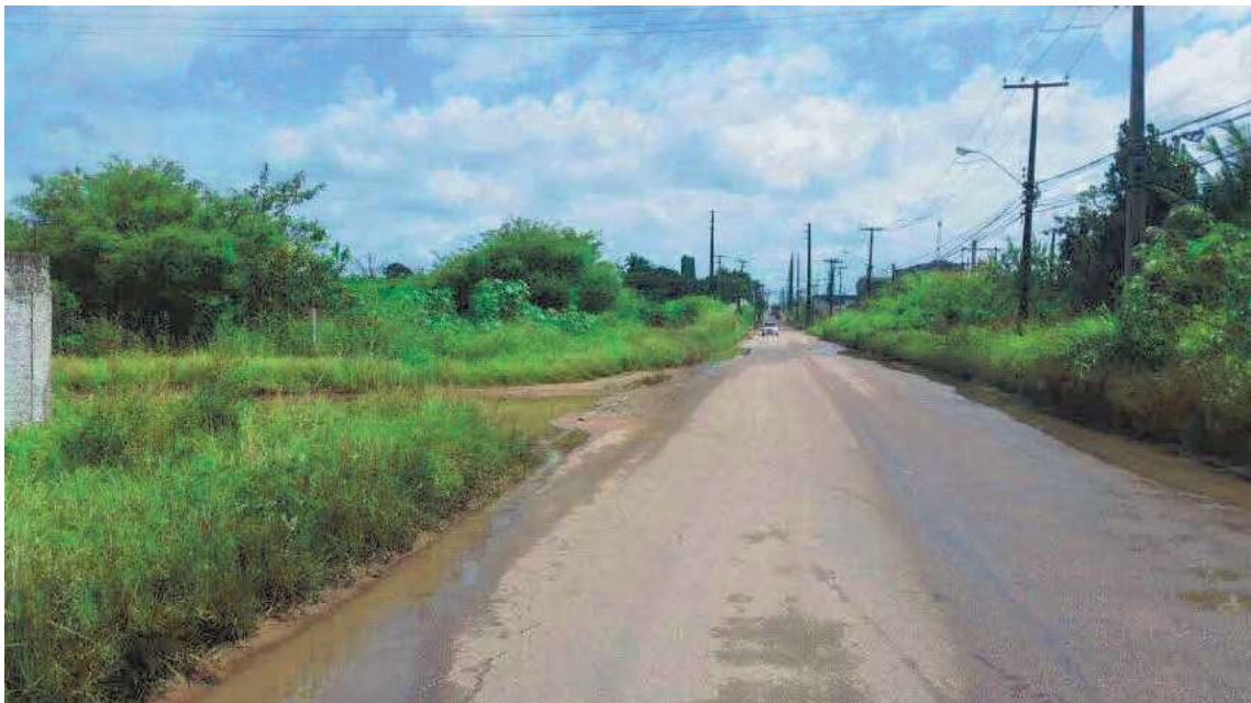
VISTA PARCIAL DA RUA B11 SENTIDO BR-101
