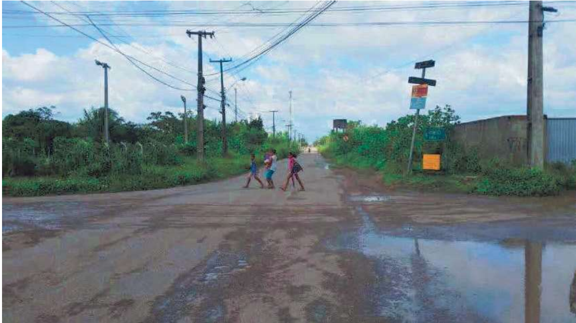
VISTA PARCIAL DA RUA B11 SENTIDO BAIRRO DAS INDUSTRIAS
