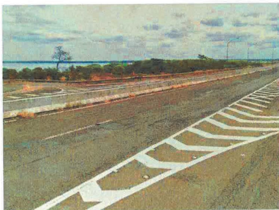
VISTA PARCIAL RODOVIA SP-320 SENTIDO APARECIDA DO TABOADO/MS – DETALHE ACESSO AO TERRENO AVALIANDO
