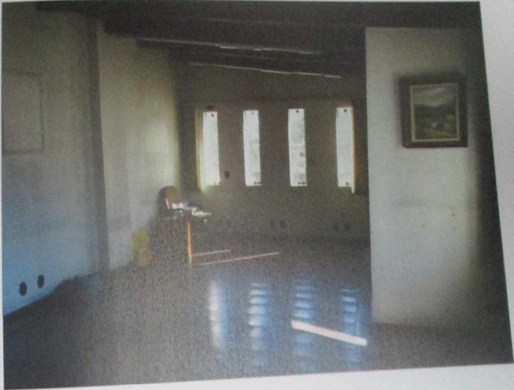
Foto 13: Vista piso superior.
