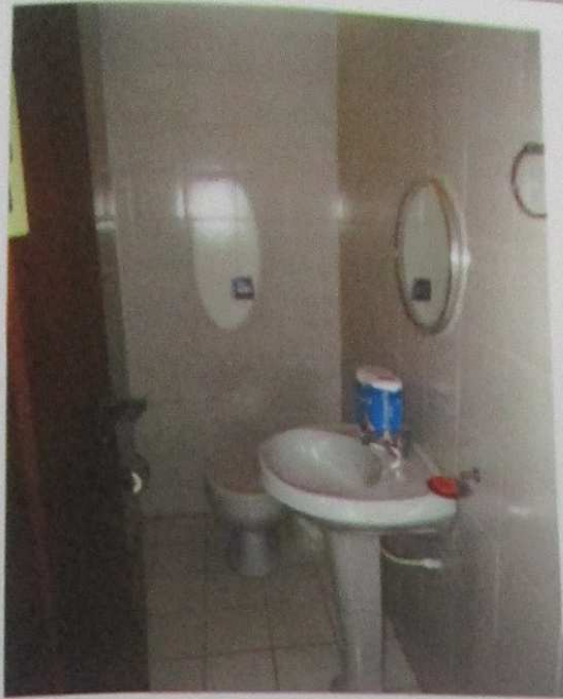
Foto 12: Vista piso superior.
