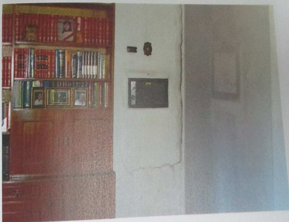
Foto 15: Vista piso superior.
