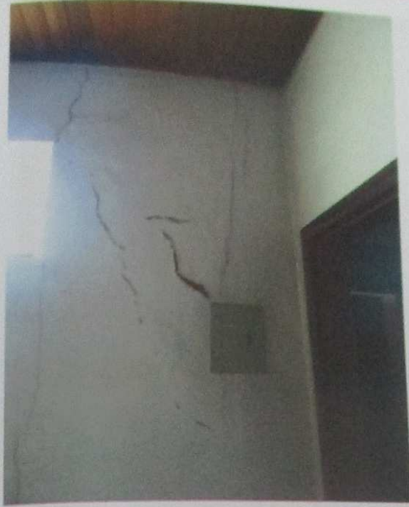
Foto 16: Vista piso superior.
