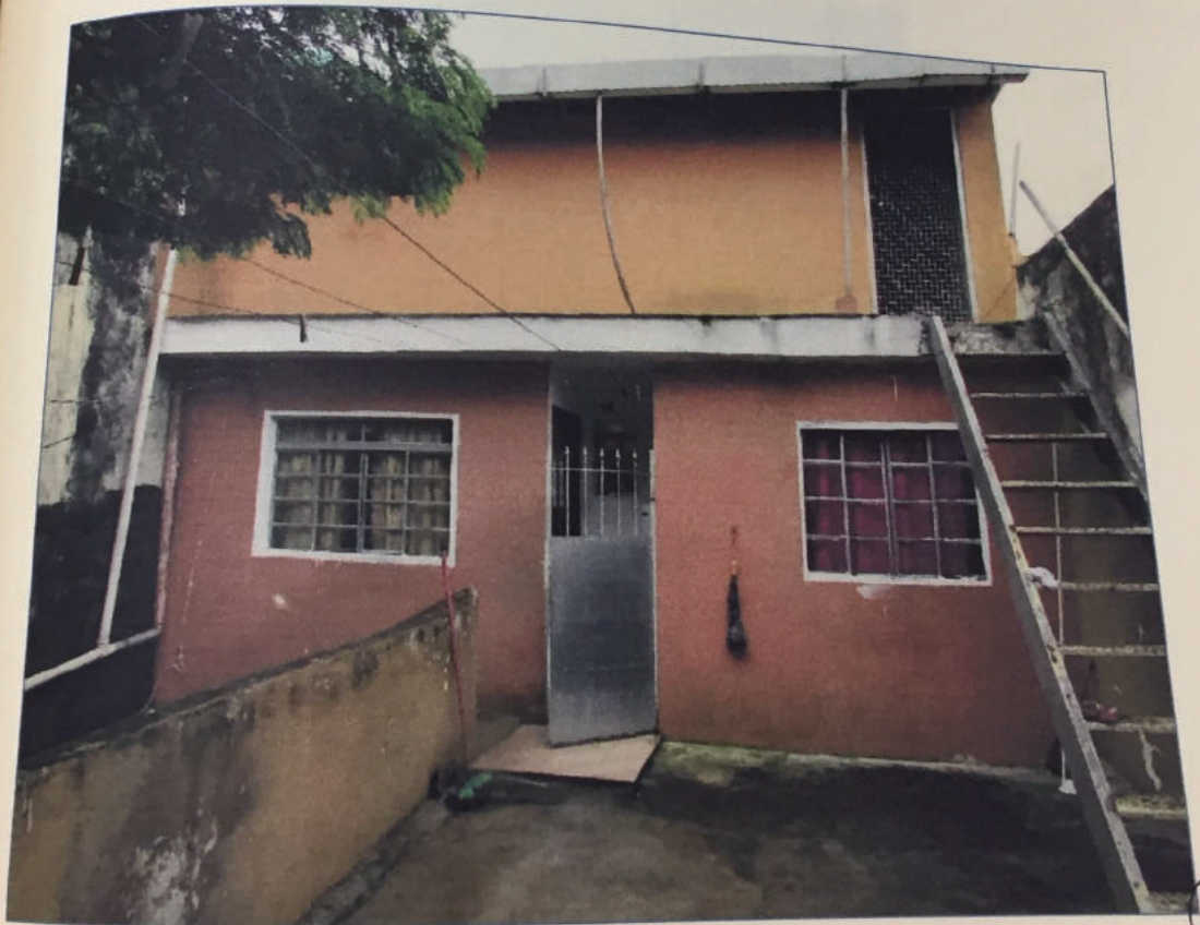
VISTA DA EDIFICAÇÃO - CASA 3.
