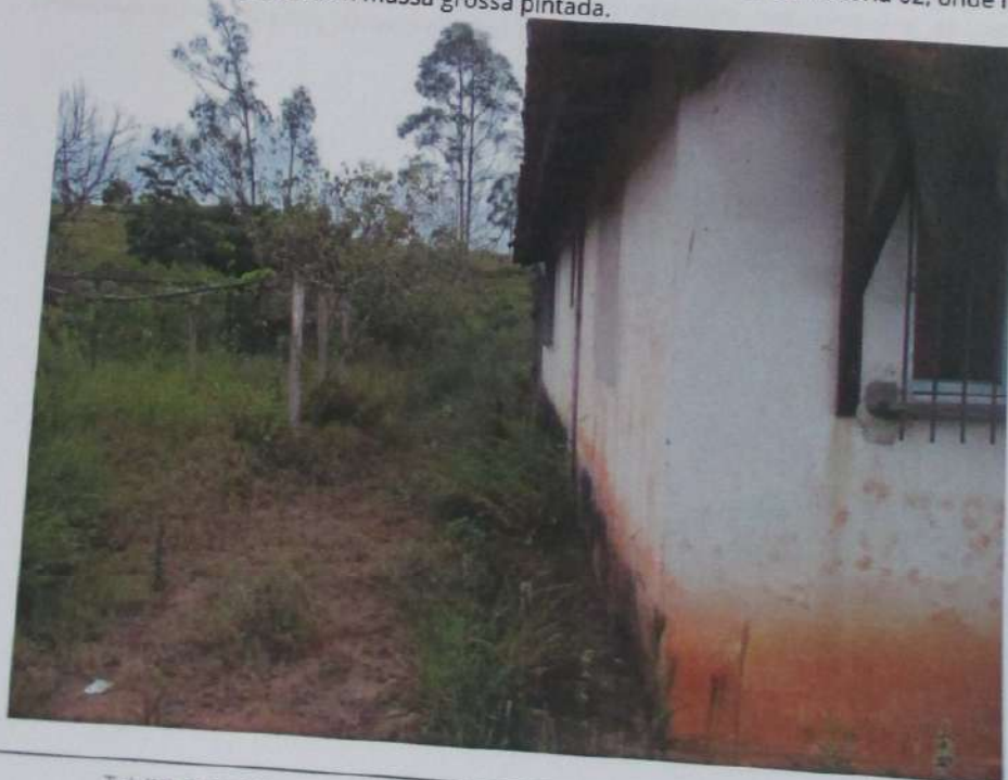
Nas imagens, acima e abaixo, tem-se outra tomada do exterior da benfeitoria 02, onde nota-se as paredes revestidas com massa grossa pintada.
