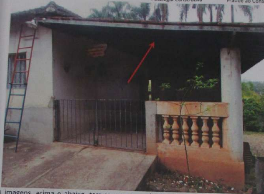
Nas imagens, acima e abaixo, tem-se uma tomada da cobertura 01, onde nota-se que a mesma é constituída de telhas de barro sobre estrutura de madeira apoiada na parede da benfeitoria 01.
