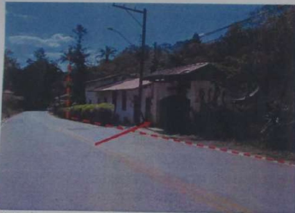
Na imagem acima, nota-se uma tomada da testada do imóvel, identificado pelo número 400, onde podemos observar a acessibilidade direta ao imóvel, bem como sua consistência seca.
