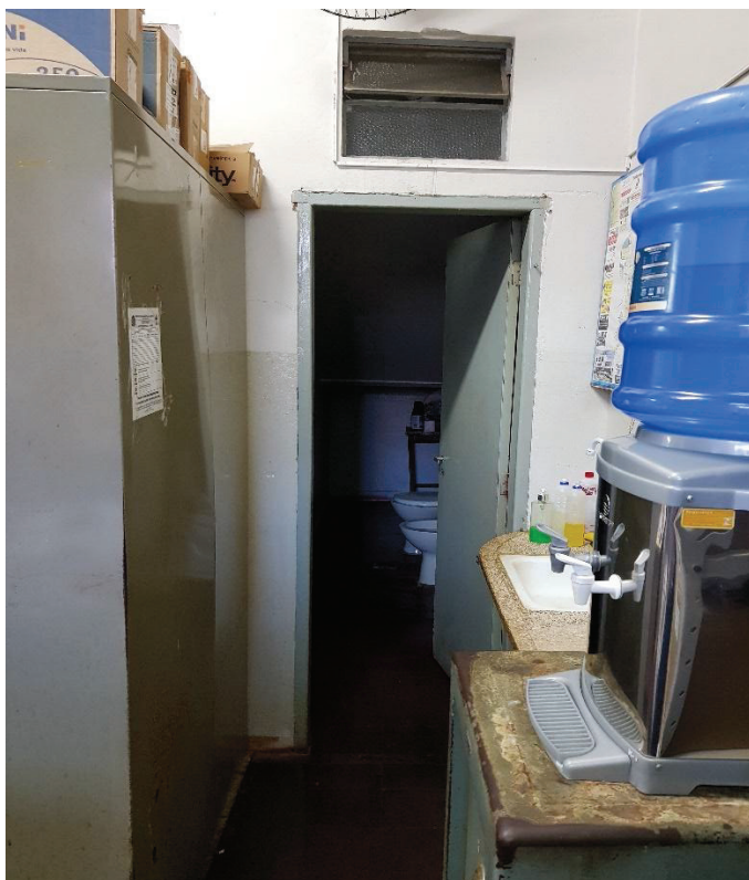
Foto 23: Vista da entrada do banheiro, localizado do lado esquerdo para quem fica de frente para a entrada da sala comercial, corredor com pia.
