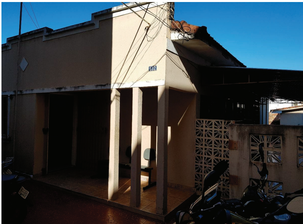
Foto 27: Vista da fachada do imóvel
