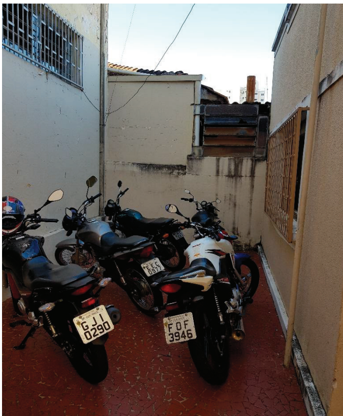
Foto 28: Detalhe do quintal na frente da edícula com piso de cacos cerâmicos, e pintura em látex nas paredes;
