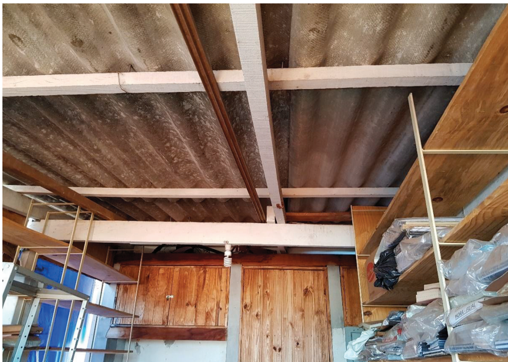
Foto 18: Detalhe da armação de madeira e da telha de fibrocimento, da cobertura da lavanderia.
