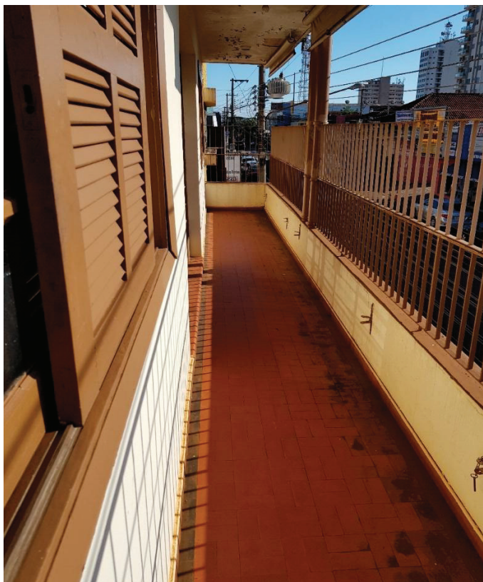
Foto 19: Vista da sacada do imóvel, que possui piso cerâmico, e corrimão de ferro, localizada na frente do imóvel.
