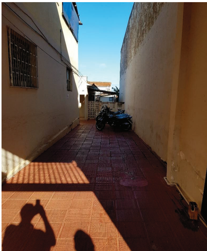
Foto 26: Vista da garagem que dá acesso ao imóvel com piso de lajotas e pintura em látex.
