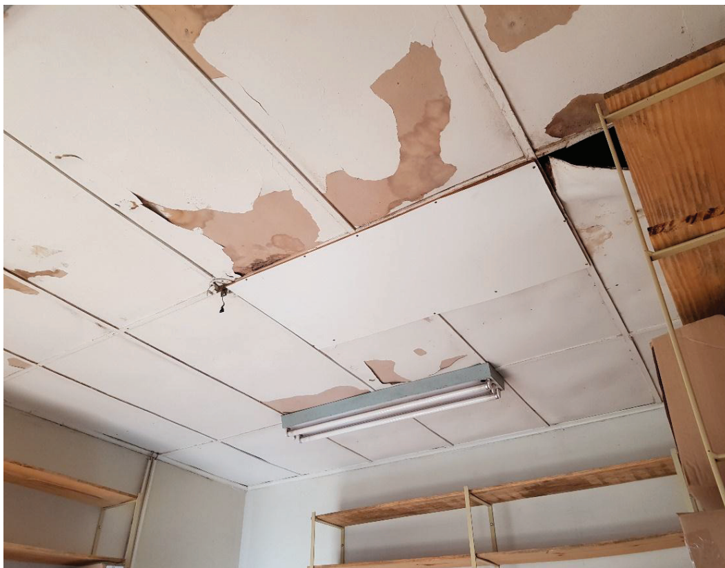
Foto 7: Detalhe do forro de placa de madeira, na Sala de Estar.
