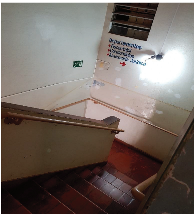
Foto 10: Detalhe da escada que dá acesso ao imóvel, com corrimão de ferro e piso cerâmico.
