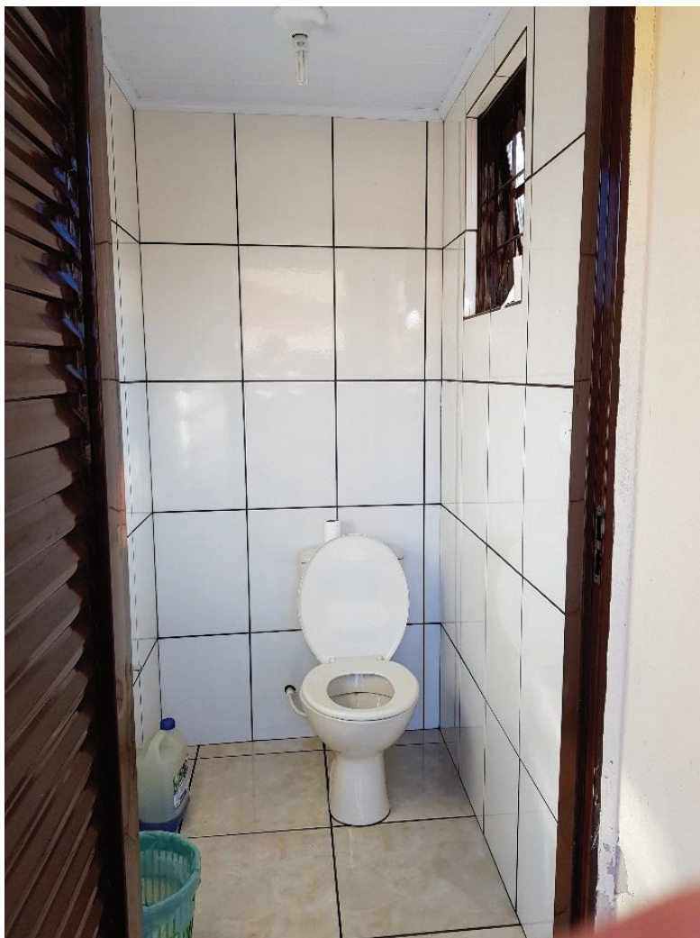
Foto 46: Detalhe do banheiro.
