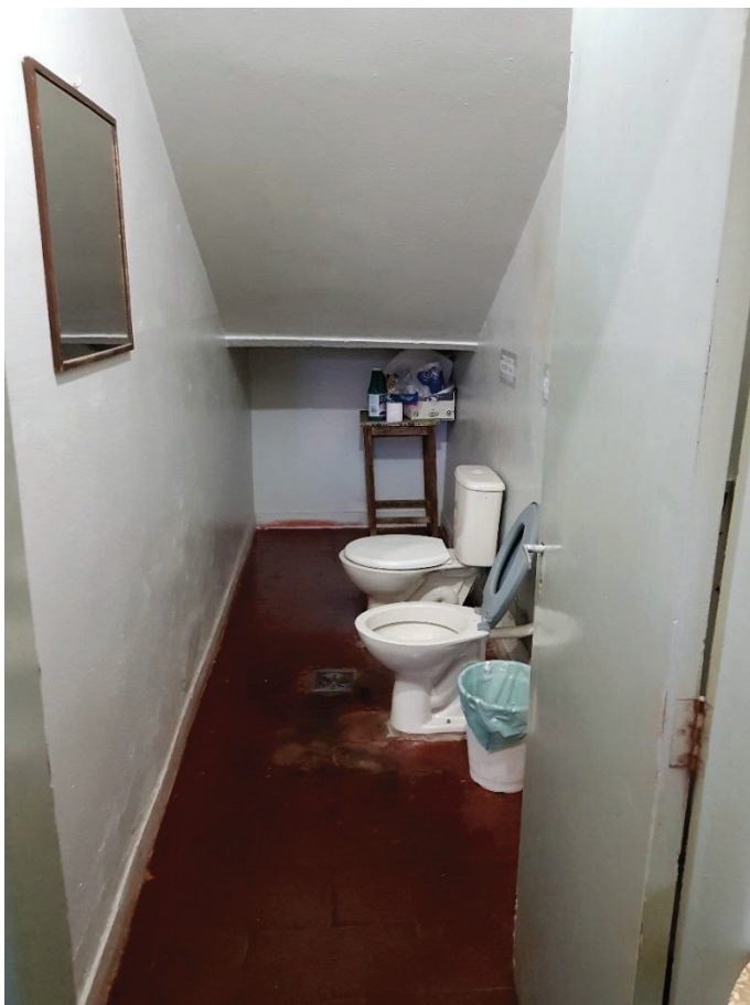
Foto 24: Vista de dentro do banheiro, que possui piso cerâmico, e pintura em látex; localizado abaixo da escada do piso superior.
