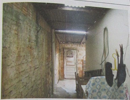
Foto 11 - Vista do corredor lateral, da frente para os fundos.
