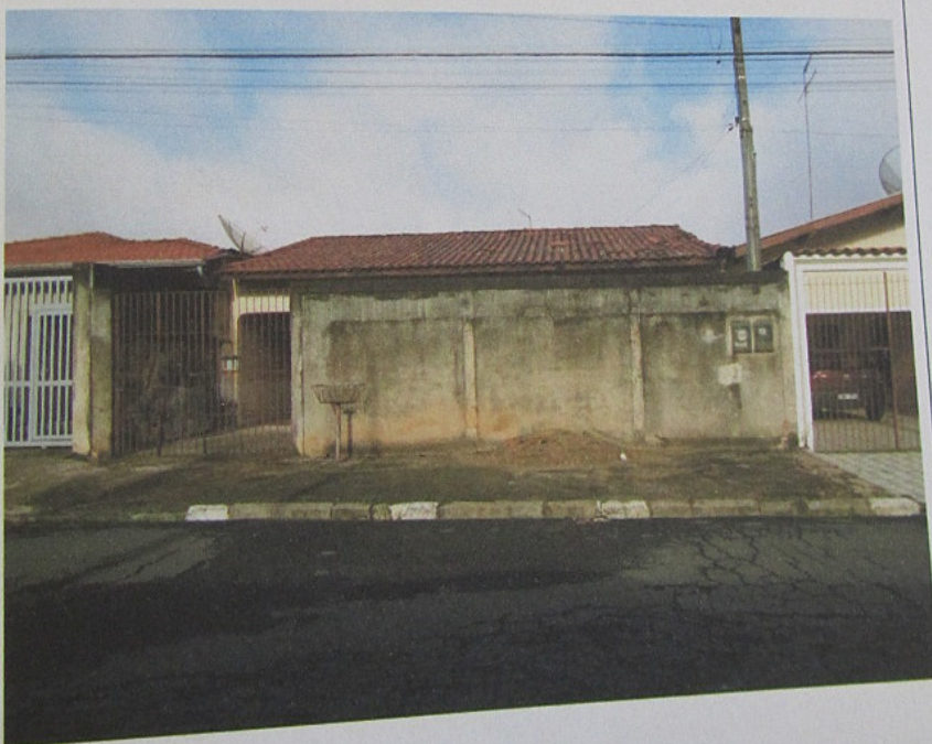
Foto 2 – Fachada do imóvel.
