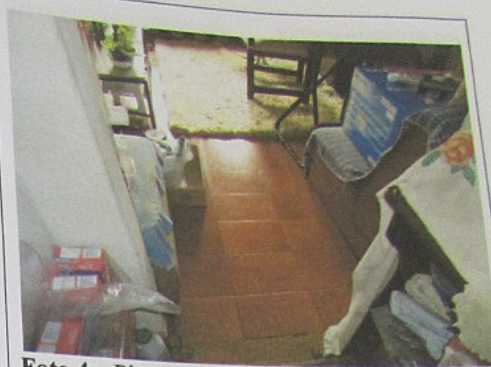
Foto 4 - Piso cerâmico da sala.
