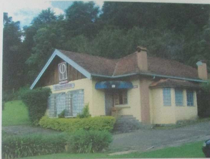
Fachada principal- com vidros, pintura e telhado reformado
