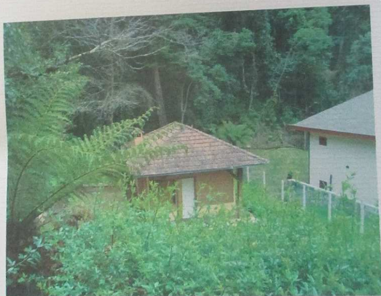
Forro reformado e telhado com telhas.
