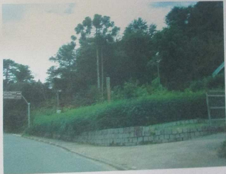
Acesso principal com portão – conforme vistoria da perita
