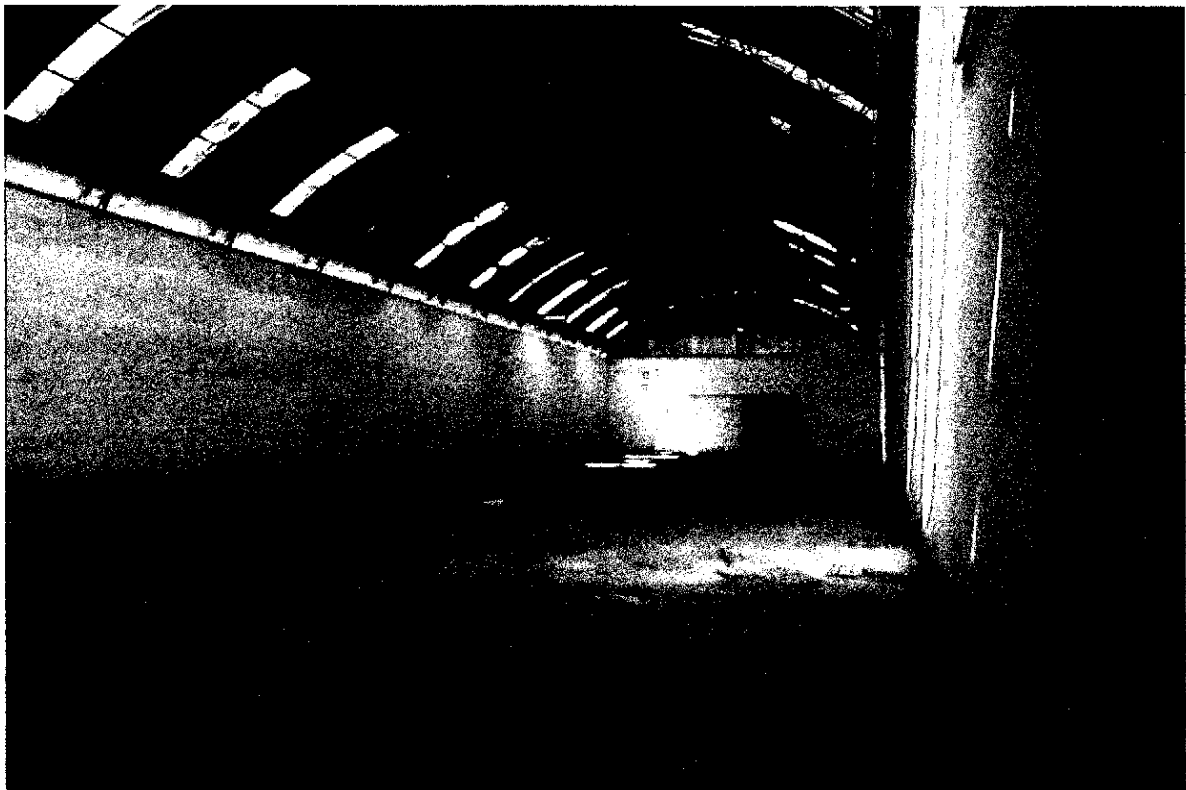
Imagem interna do Barracão nº 01.
