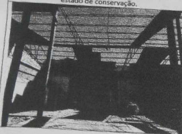
Vista do telhado no galpão 1, área secundária.
