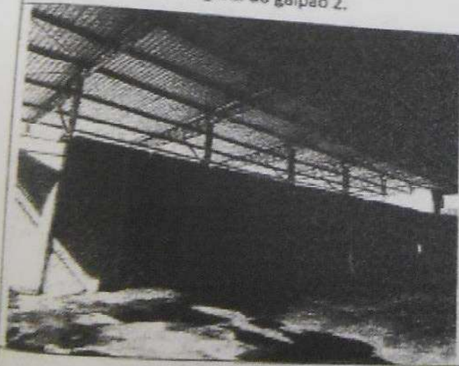
Vista geral do galpão 2.
