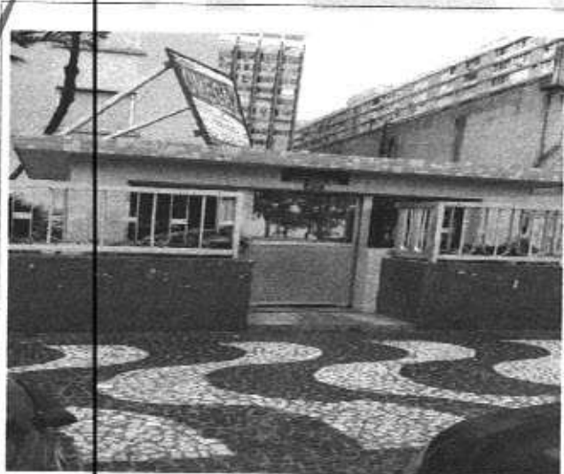
Guarita entrada Av. Bartolomeu de Gusmão
