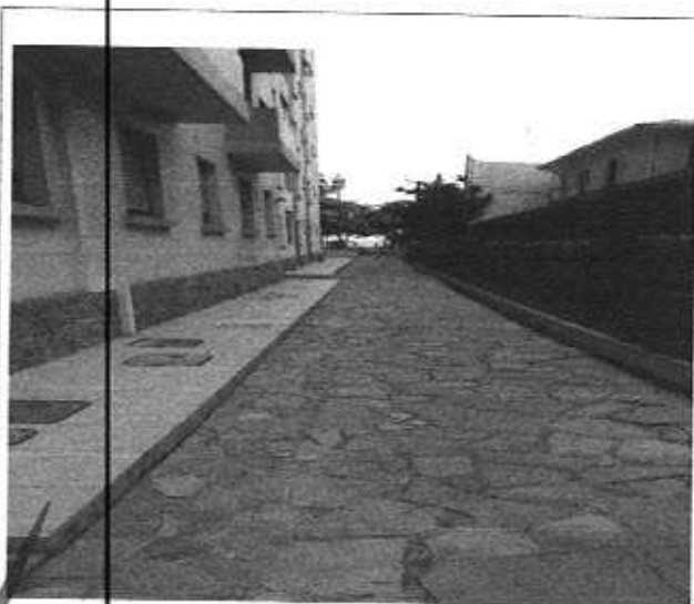
Corredor de acesso
