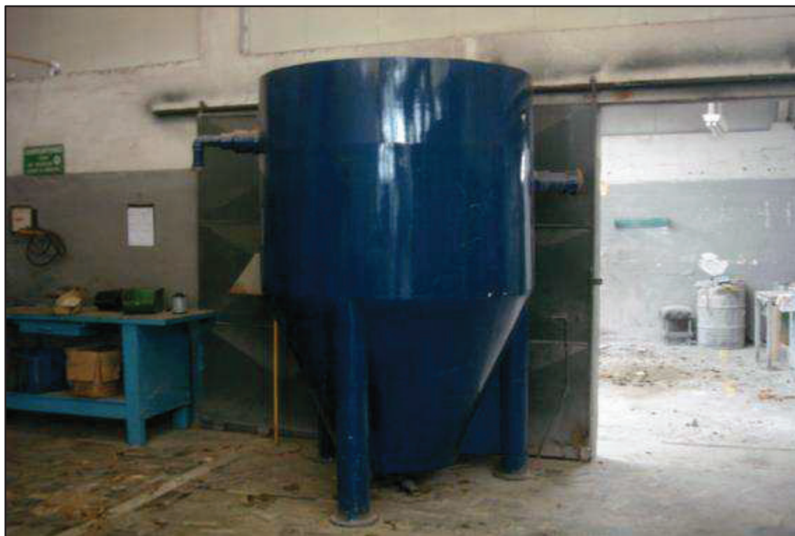
ITEM 5,357 - VISTA DO TANQUE INACABADO APROXIMADAMENTE 3000L
