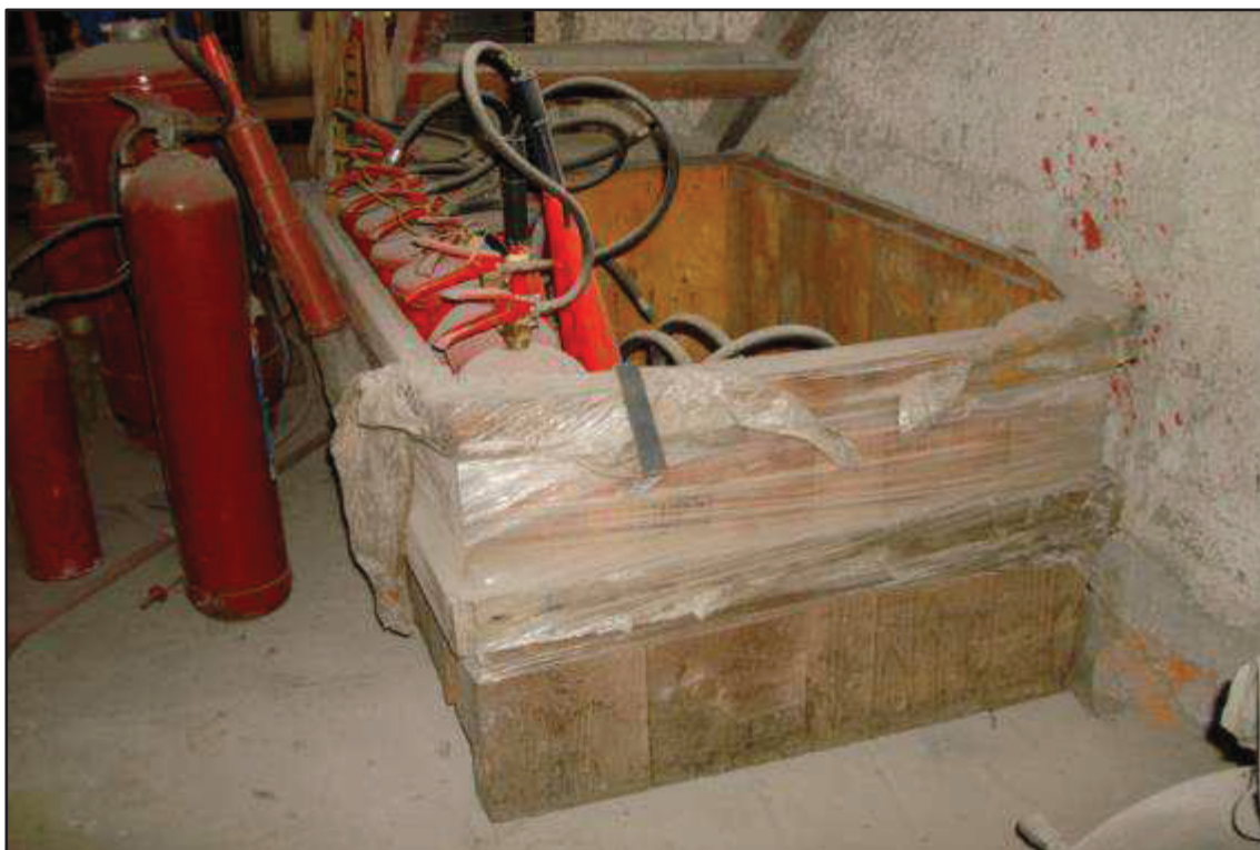
ITEM 5,011 AO 5,013 - VISTA DO EXTINTOR CLASSE 2A, DO EXTINTOR PÓ QUÍMICO E DO EXTINTOR CO2
