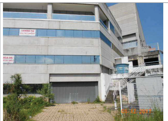
Acesso Garagem "Pav. Subsolo"
