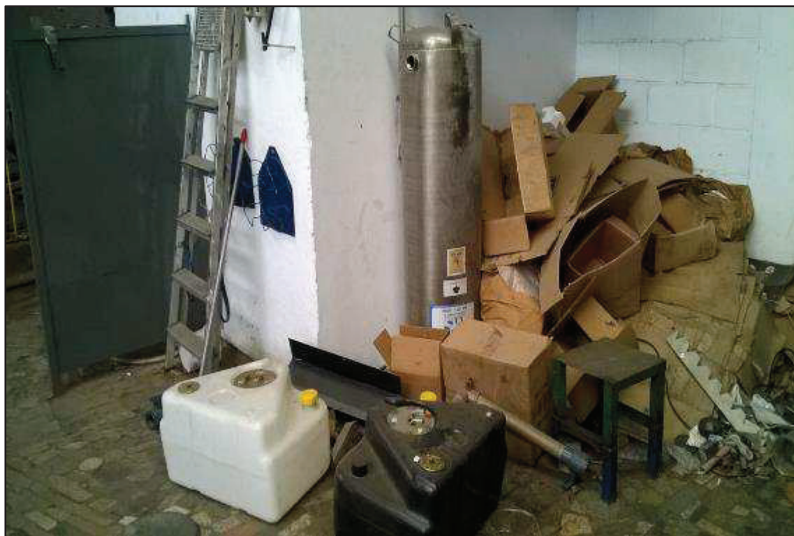
ITEM 5,370 E 5,371 - VISTA DO TANQUE ALUMÍNIO E DO TANQUE DE COMBUSTÍVEL PARA AUTO
