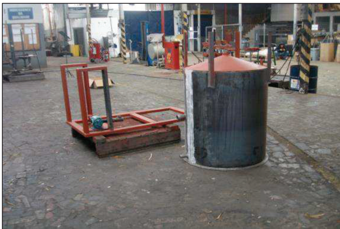
ITEM 5,356 - VISTA DO TANQUE E ESTRUTURA INACABADOS
