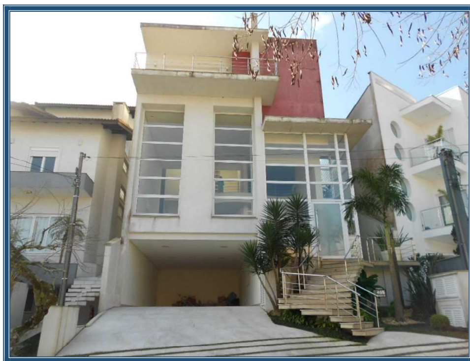
Vista da frente do imóvel avaliando.
