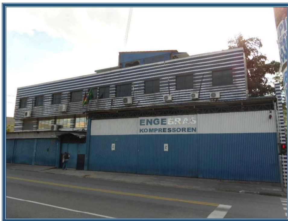
Vista da frente do imóvel avaliando.
