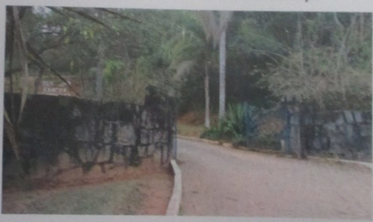
FOTO VISTA PORTÃO DE ENTRADA
