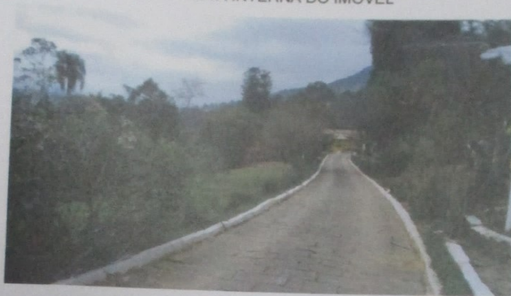
FOTO VISTA INTERNA DO IMÓVEL
