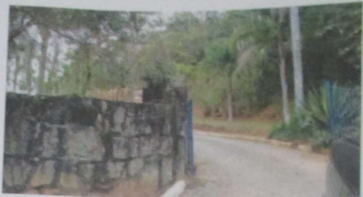
FOTO VISTA PORTÃO DE ENTRADA
