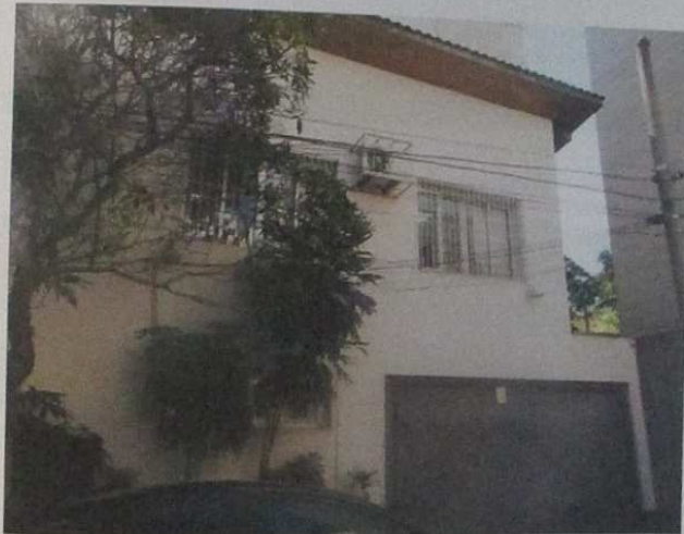
Foto nº 6 – Fachada frontal – vista da garagem.
