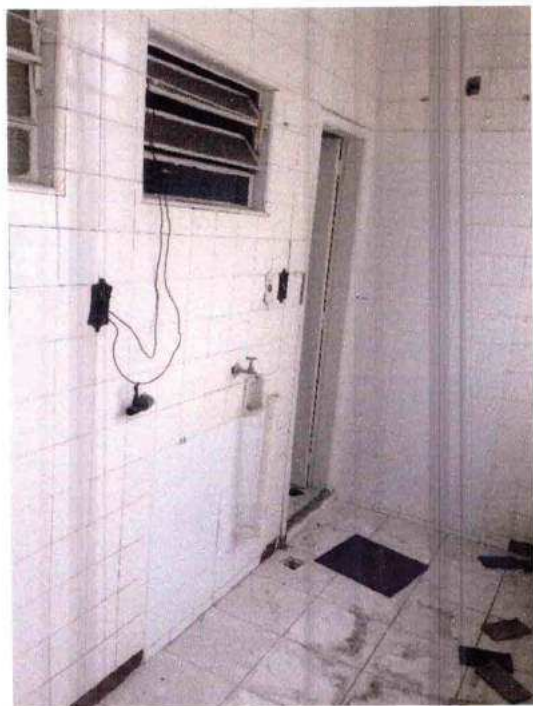
FOTO 53 – Área de Serviços – fundos
