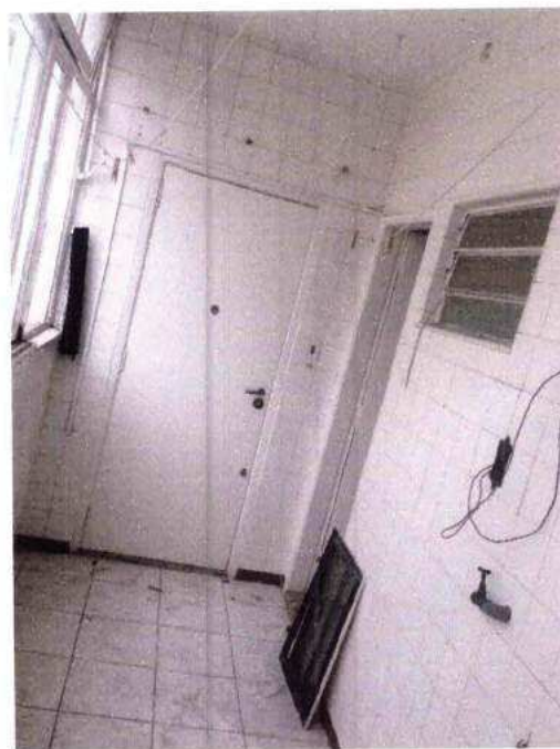
FOTO 54 – Área de Serviços – fundos
