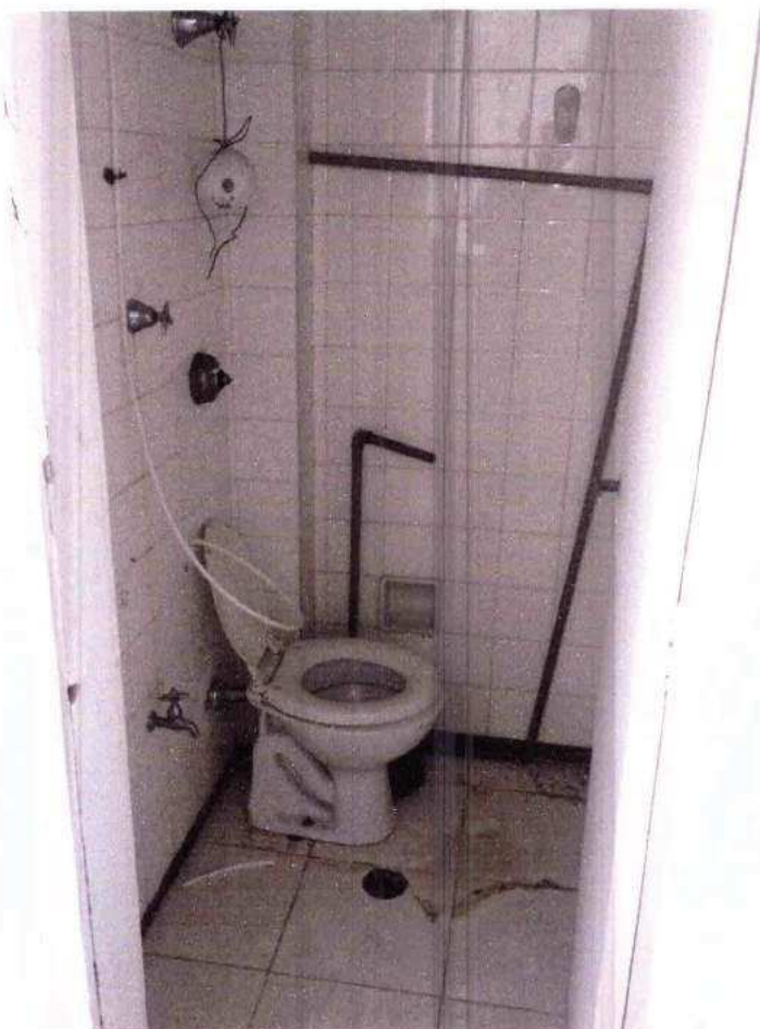
FOTO 55 – WC Área de Serviços – fundos
