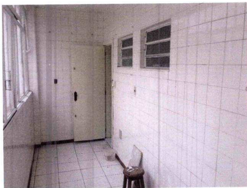
FOTO 12 – Área de Serviços
