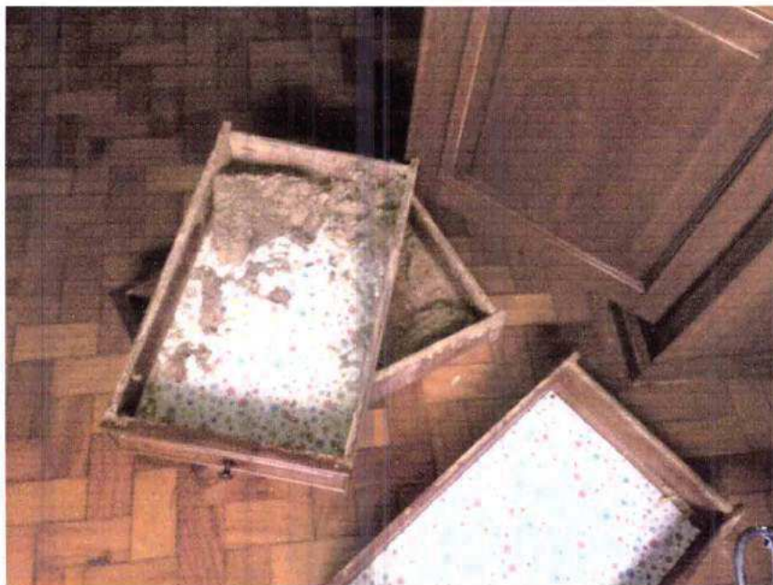
FOTO 23 – Closet – cupim na madeira armários
