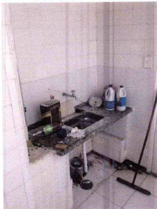
FOTO 13 – Área de Serviços - pia
