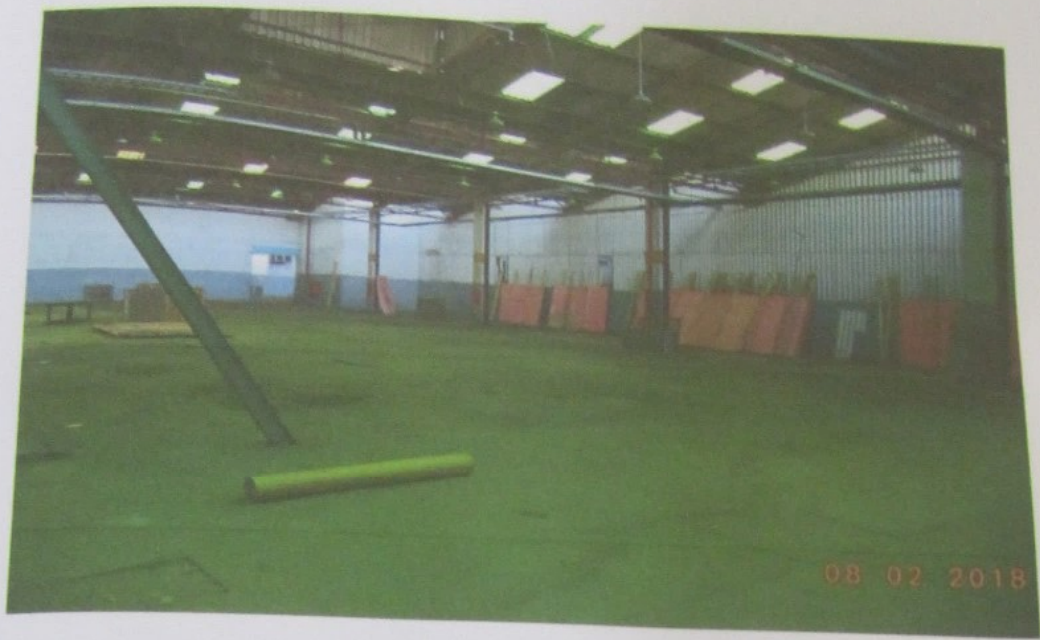
Foto 22 - Prédio 1 -Galpão 1 - Área de fabricação
