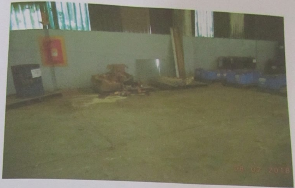
Foto 47 - Prédio 9 - Galpão 9 - Almojarifado Vista Interna
