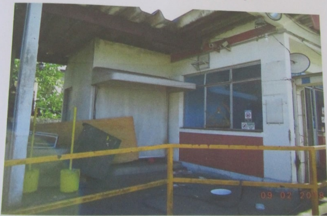
Foto 50 - Prédio 10 - Posto Bancário ao lado da Portaria
