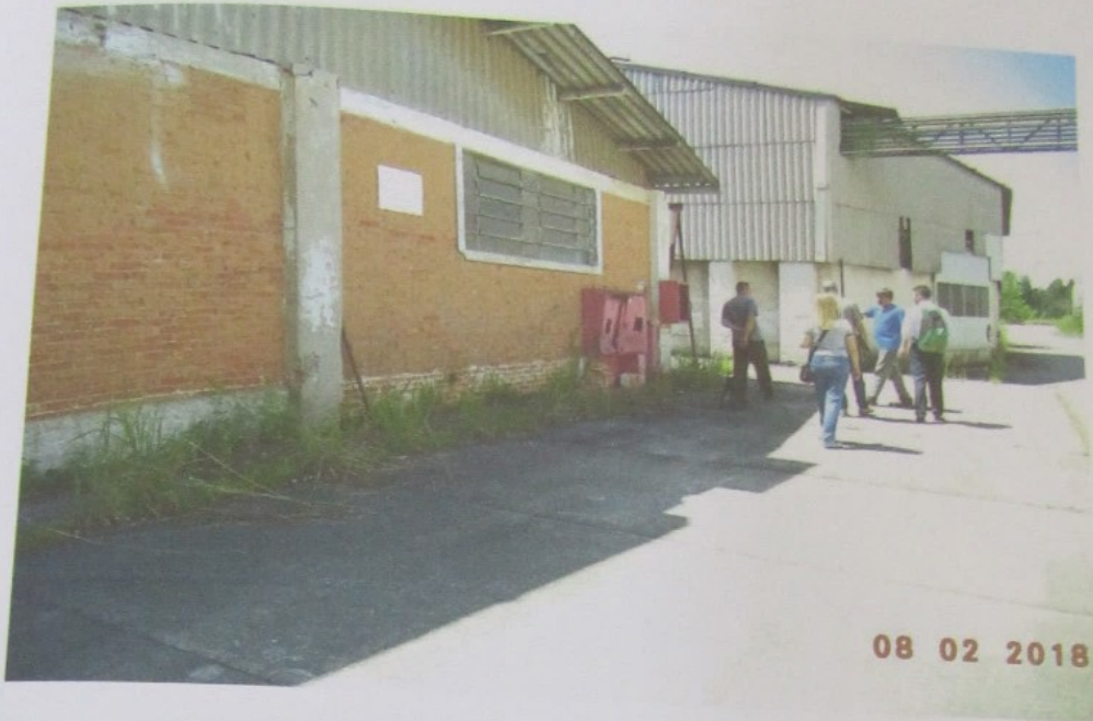
Foto 71 - Prédio 19 (ao fundo) - Galpão de Utilidades
