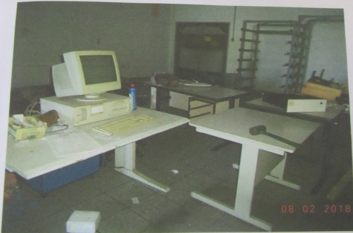
Foto 14 - Pavimento Térreo - Setor Fotografia
