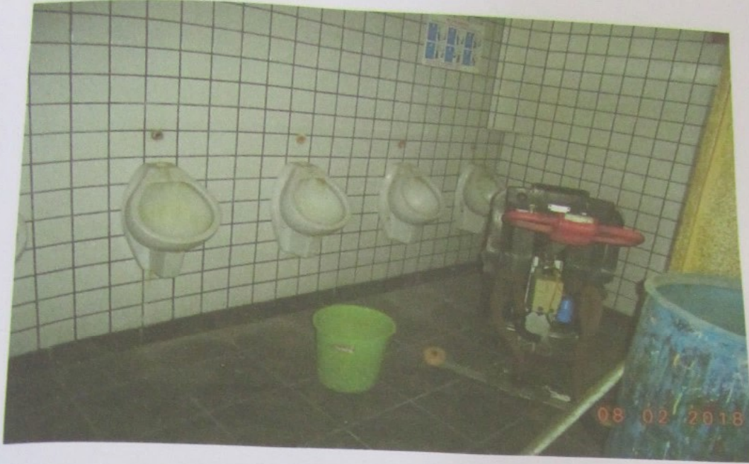
Foto 13 - Pavimento Térreo - WC Masculino
