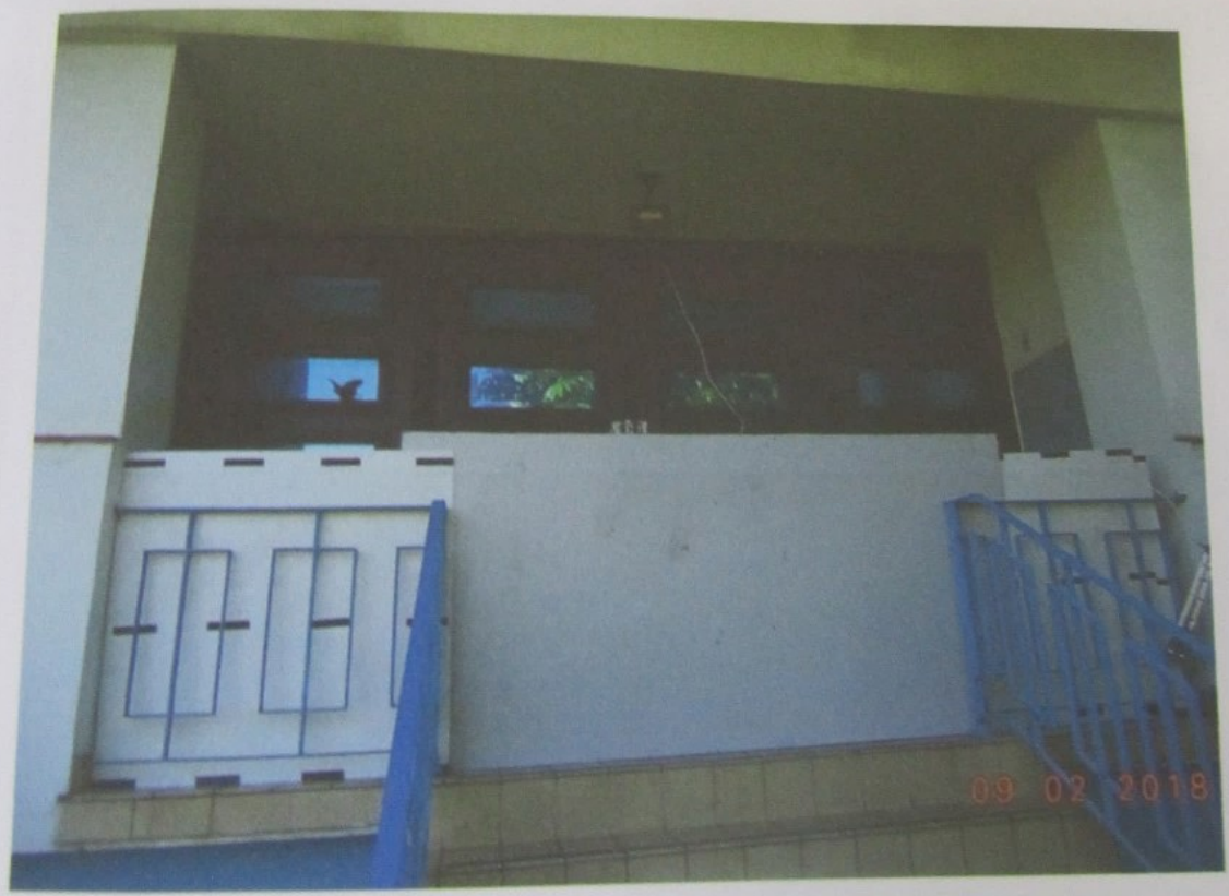
Foto 4 - Entrada Pavimento superior, escritórios
