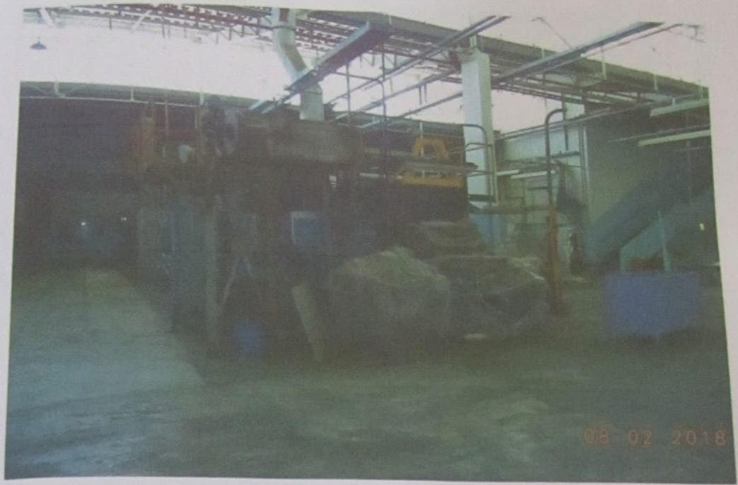
Foto 19 - Prédio 1 - Galpão 1 - Área de fabricação
