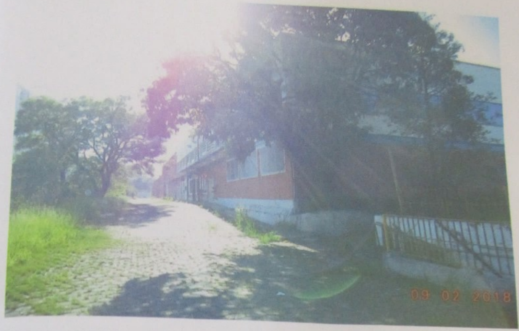
Foto 3 - Fachada lateral esquerda prédio 1, observando o prédio de frente
