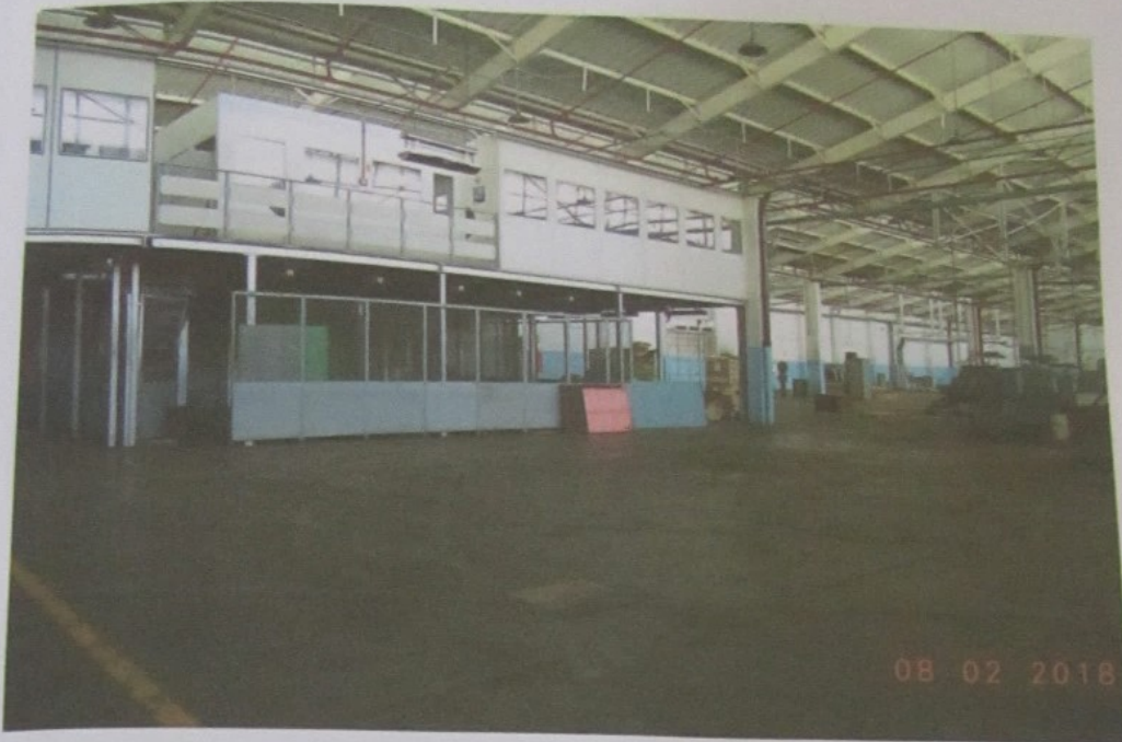
Foto 17 - Prédio 1 - Galpão 1 - Área de fabricação
