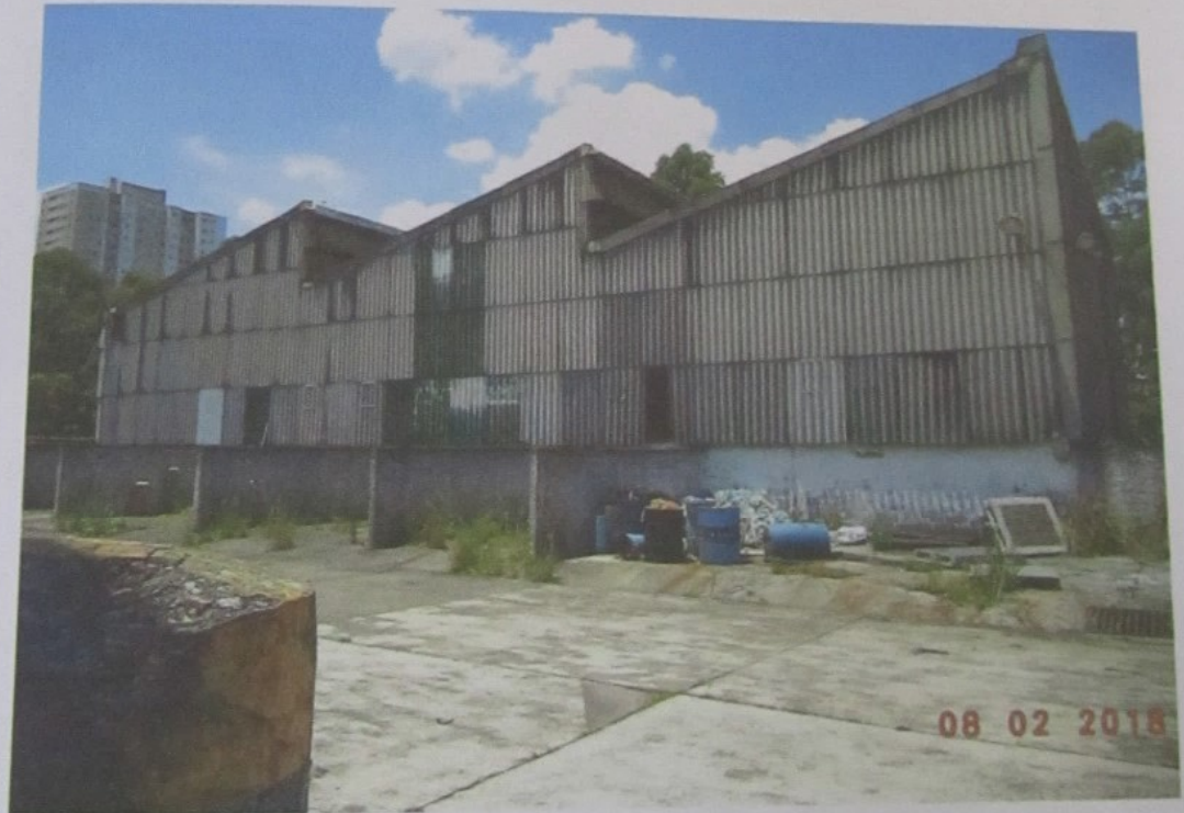
Foto 48 - Prédio 9 - Galpão 9 - Lateral do Galpão
