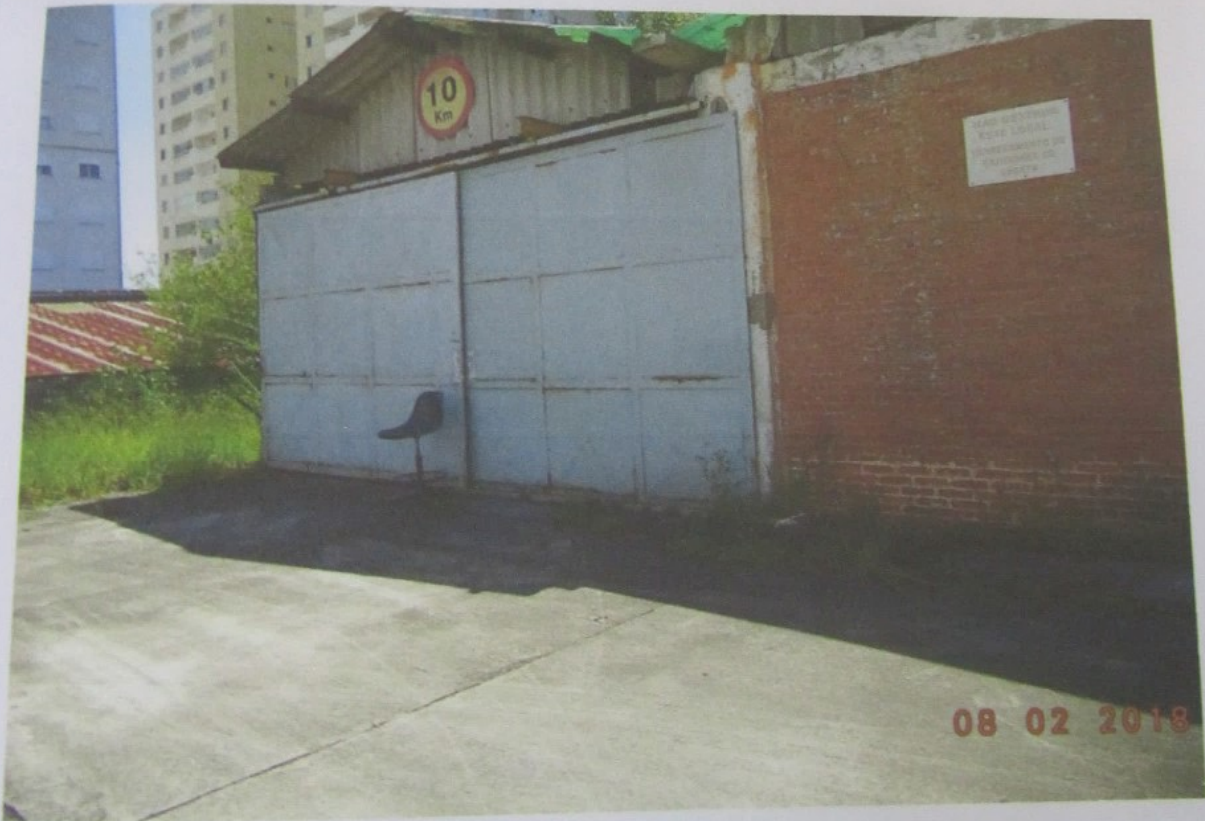
Foto 29 - Prédio 3 - Fachada Galpão 3
