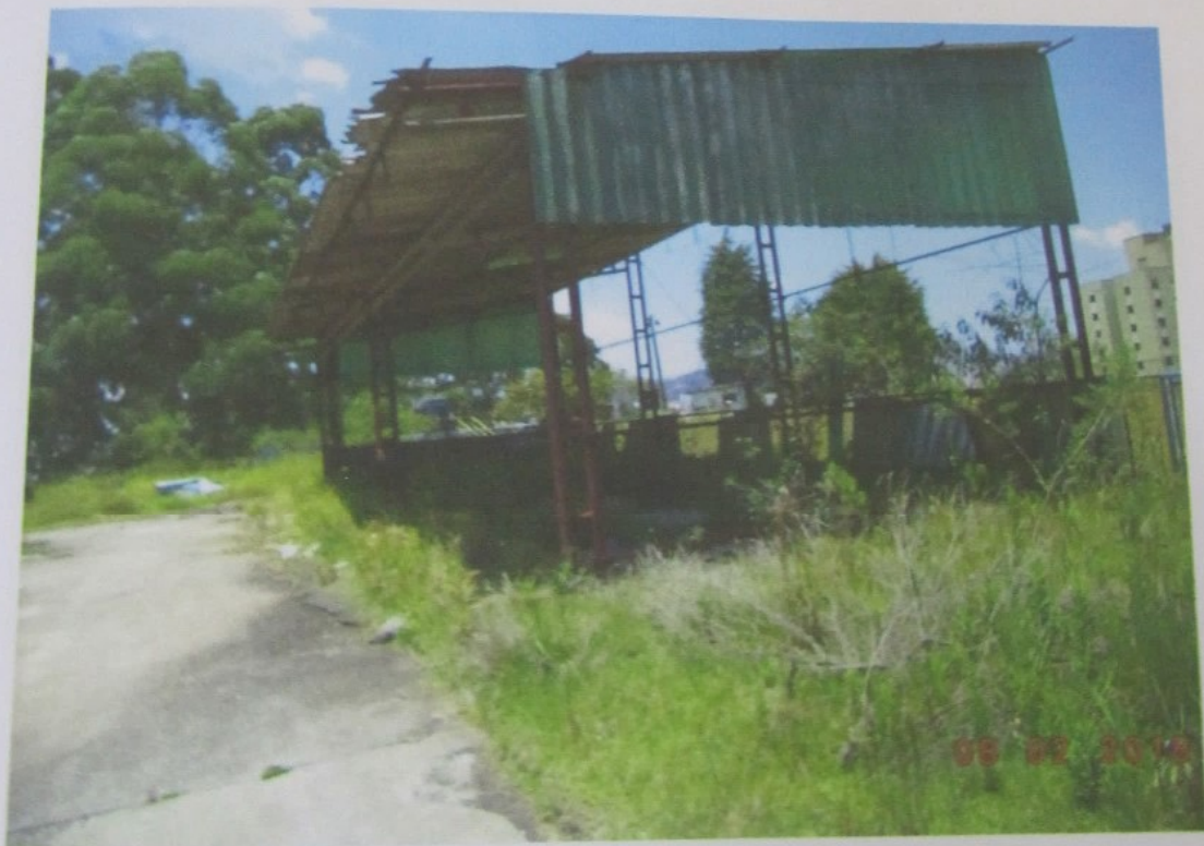
Foto 76 - Prédio 22 - Galpão Industrial
