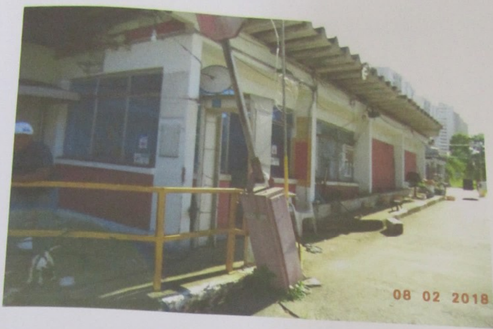
Foto 49 - Prédio 10 - Portaria Principal
