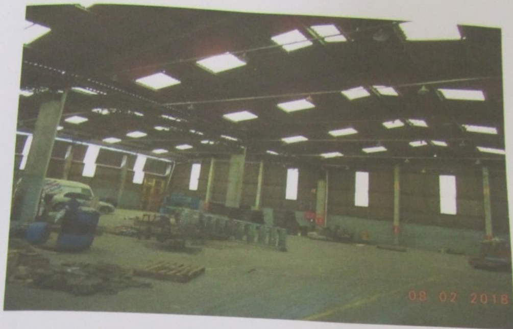
Foto 69 - Prédio 17 - Área interna Galpão Industrial
