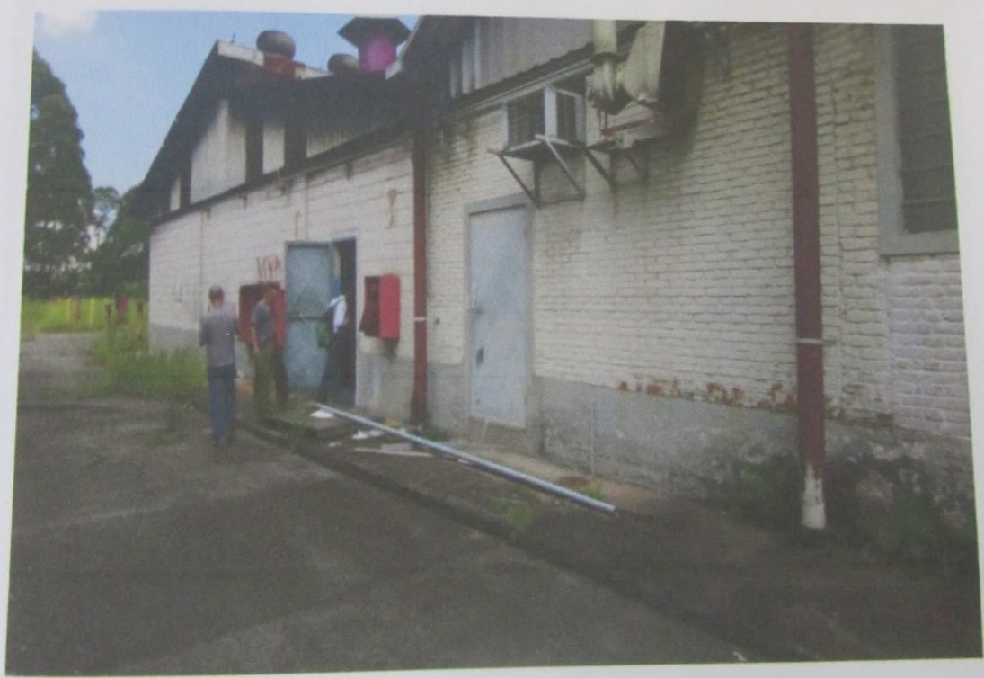
Foto 54 - Prédio 12 - Galpão 12 - Fábrica de Tintas
