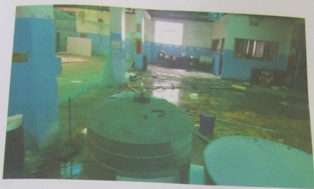
Foto 57 - Prédio 12 - Interior Galpão 12
