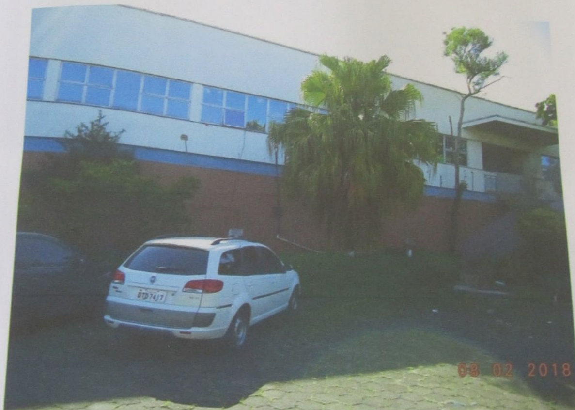
Foto 2 - Fachada e estacionamento prédio 1
