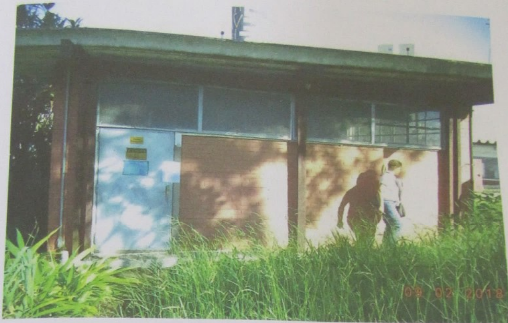
Foto 40 - Prédio 6 - Entrada Cabine de Força
