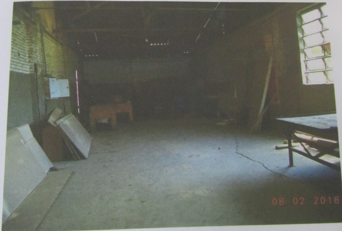
Foto 31 - Predio 3 - Galpão 3 - Carpintaria
