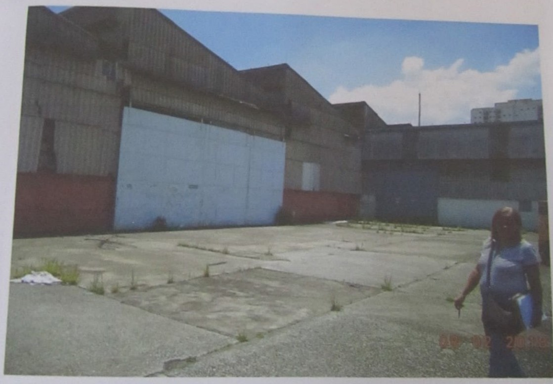
Foto 25 - Prédio 2 - Galpão 2 Almojarifado Matéria Prima
