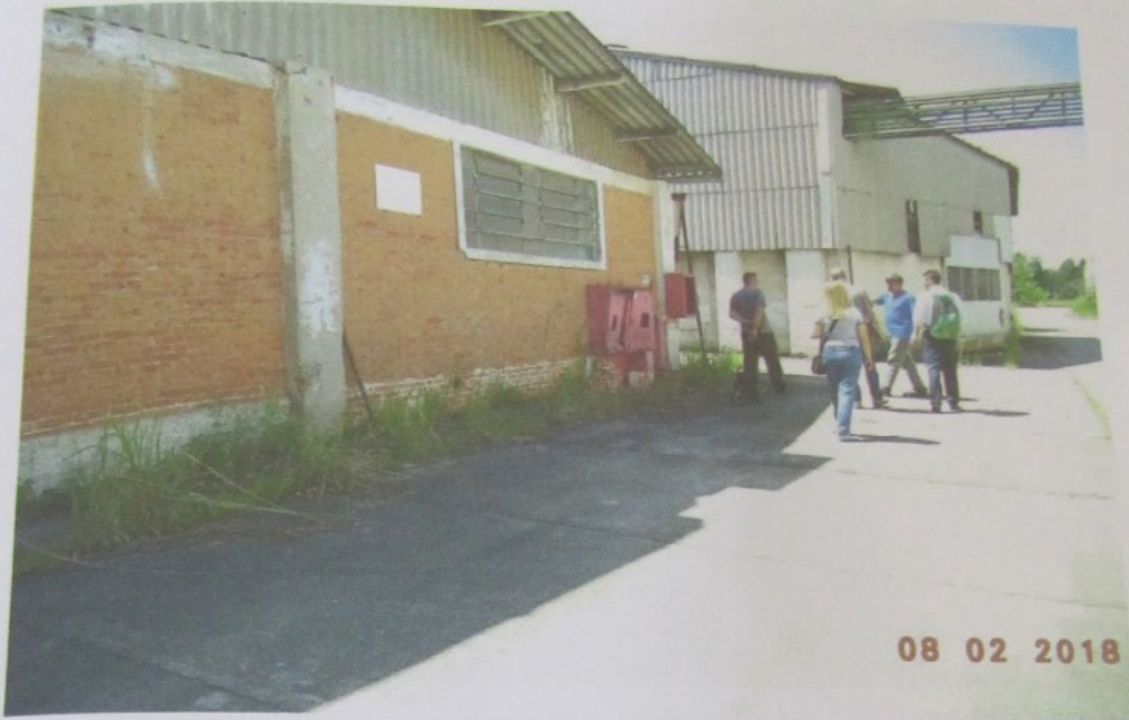
Foto 30 - Continuação da Fachada Prédio 3 - Galpão 3
