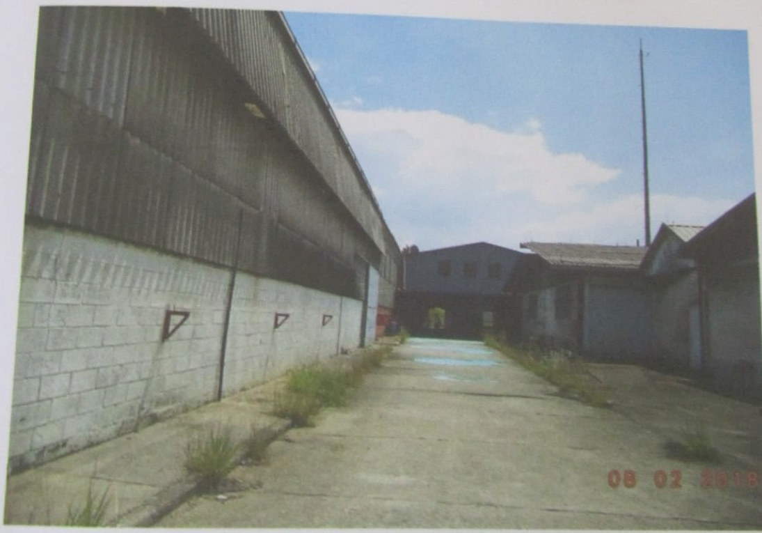
Foto 70 - Prédio 17 - Lateral do Galpão Industrial
