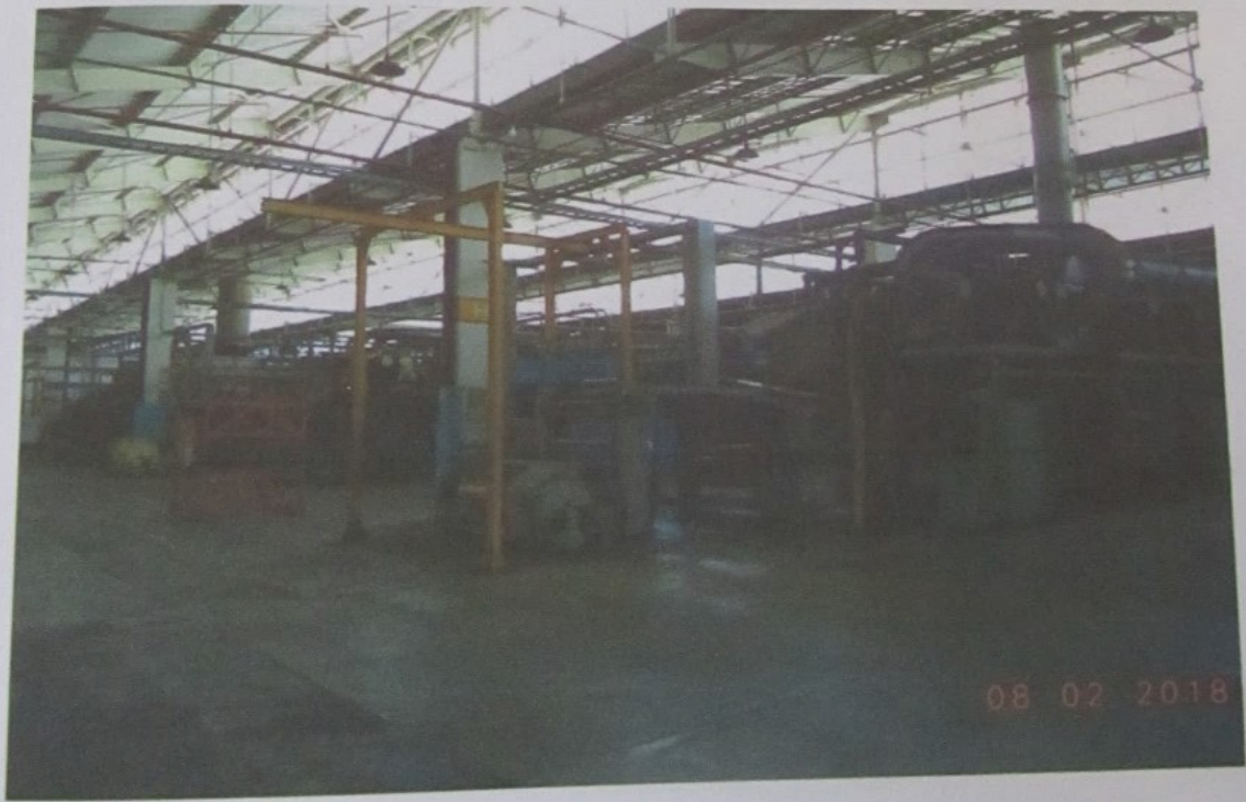
Foto 19A- Prédio 1 - Galpão 1 - Área de fabricação
