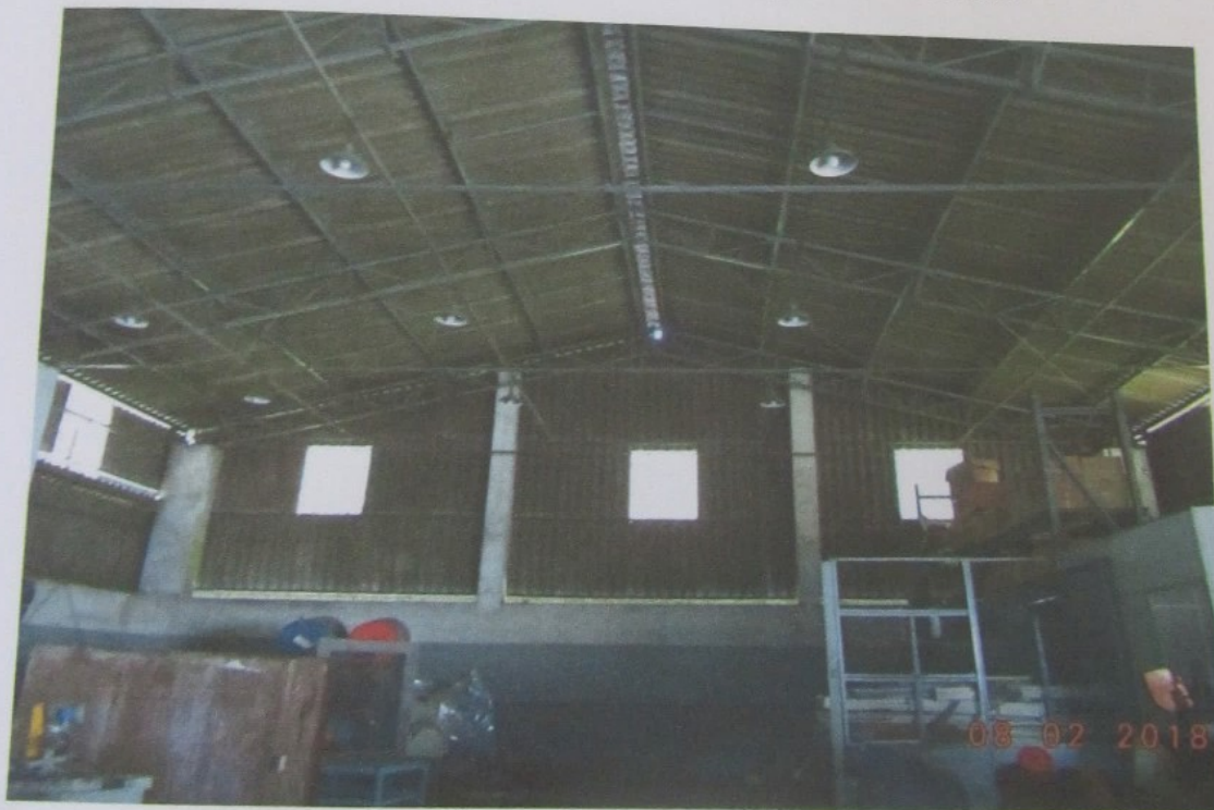
Foto 72 - Prédio 19 - Área interna do Galpão de Utilidades
