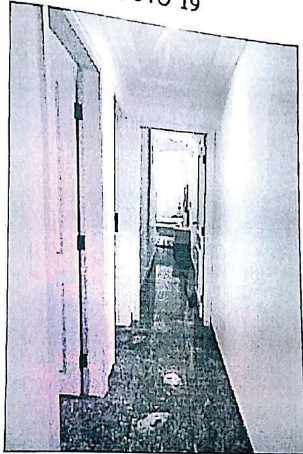
HALL DE CIRCULAÇÃO.
