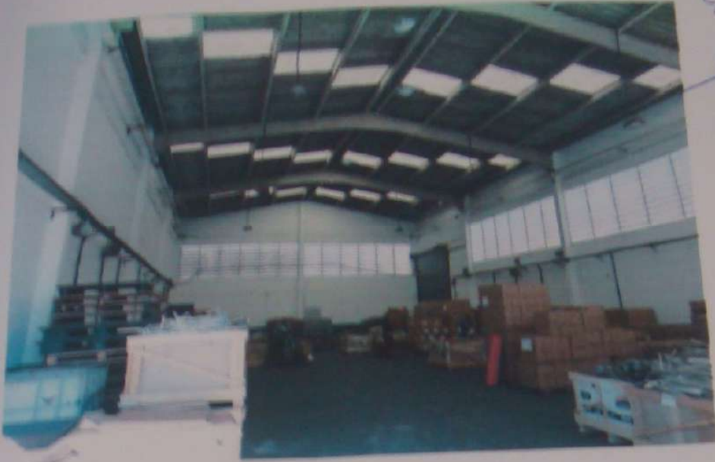
FOTO N º 19 - VISTA PARCIAL INTERNA GALPÃO.
