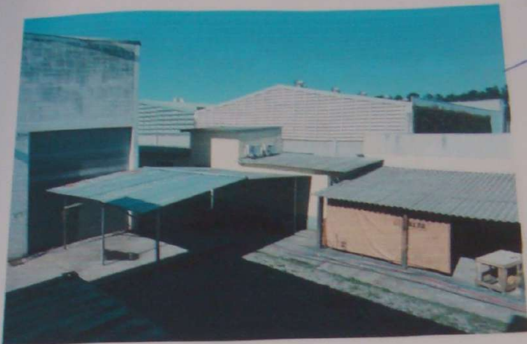
FOTO N º 17 - VISTA PARCIAL VESTIÁRIOS EXTERNOS.
