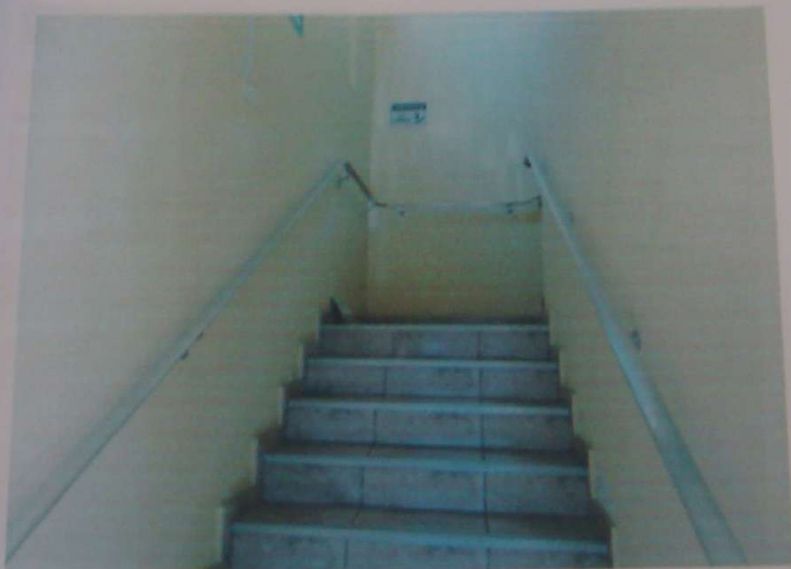
FOTO N º 10 - VISTA PARCIAL INTERNA ACESSO A PAV. SUPERIOR.
