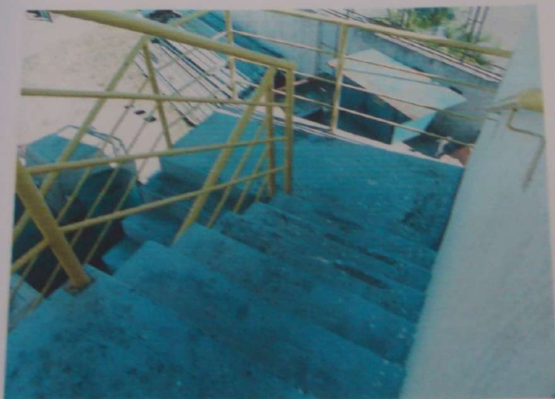
FOTO N º 16 - VISTA PARCIAL EXTERNA ESCADA DE EMERGÊNCIA.
