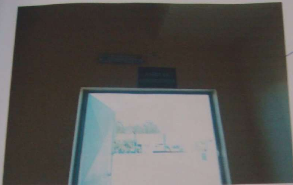
FOTO N º 15 - VISTA PARCIAL INTERNA SAIDA DE EMERGÊNCIA - PAV. SUPERIOR.
