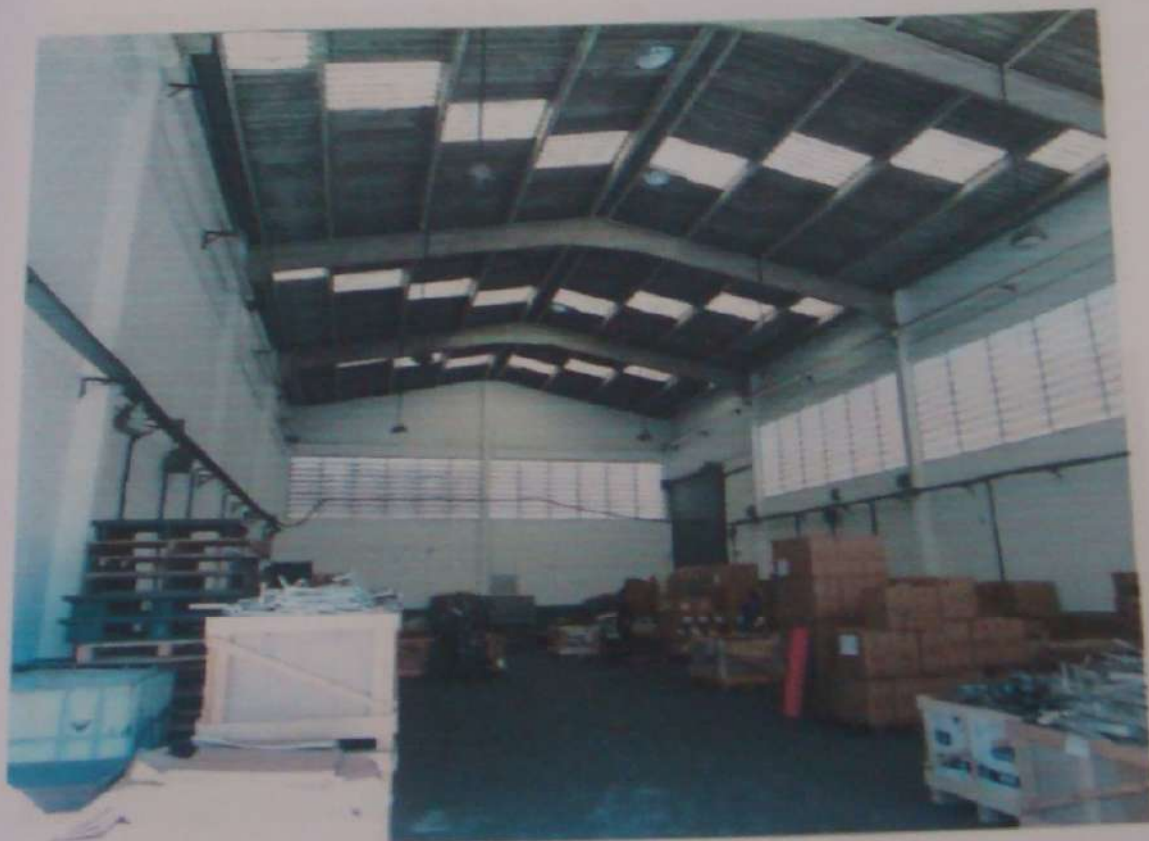
FOTO N º 18 - VISTA PARCIAL INTERNA GALPÃO.
