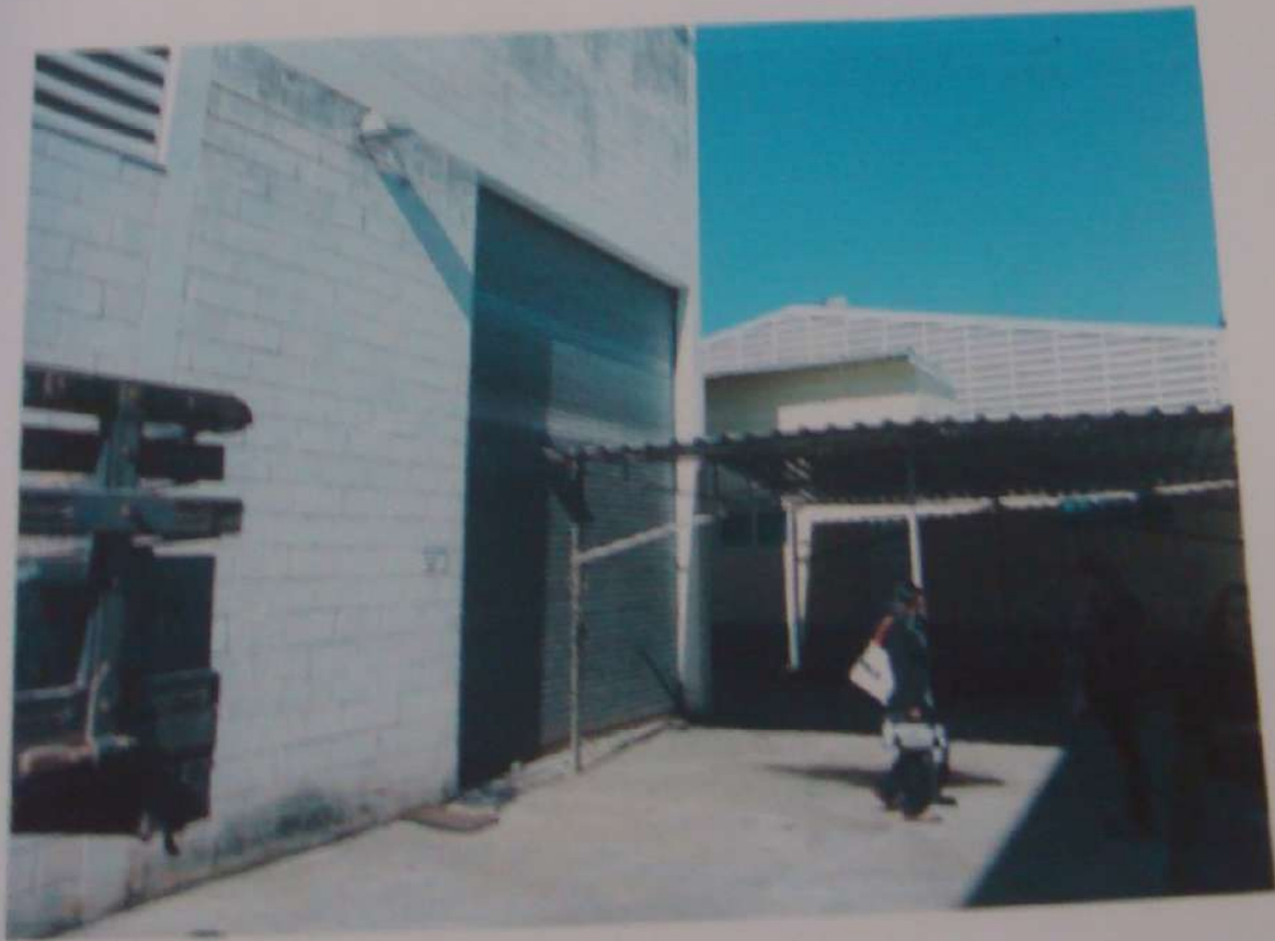
FOTO N º 20 - VISTA PARCIAL EXTERNA ACESSO GALPÃO AO ADMINISTRATIVO.
