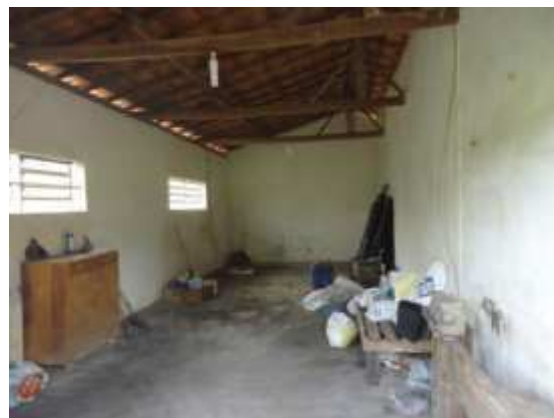
20. Vista interna do depósito
