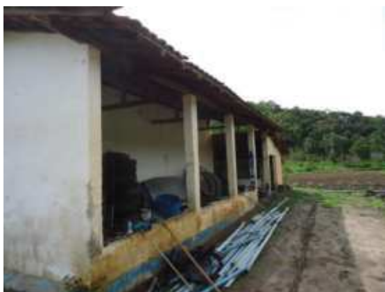
21. Vista interna do depósito
