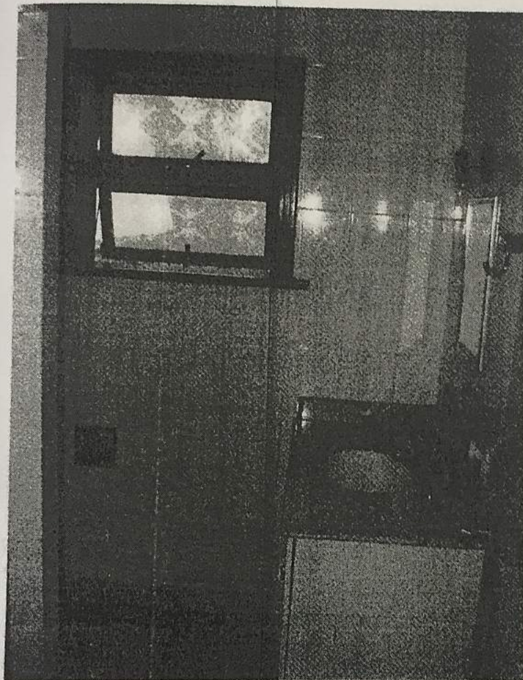
FOTO 47: BANHEIRO DE EMPREGADA.
