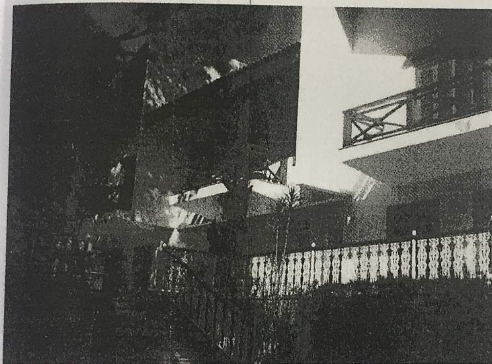
OTO 14: VISTA PARCIAL DO IMÓVEL EM QUESTÃO.
