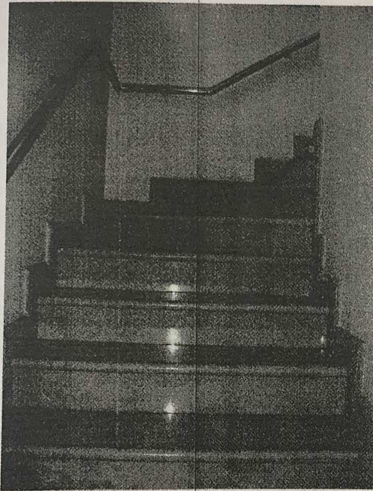
FOTO 21: ESCADA DE ACESSO AO PAVIMENTO SUPERIOR.
