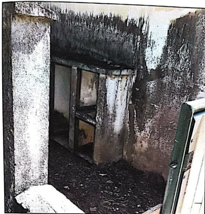
FOTO 08: DETALHE DO CORREDOR LATERAL
