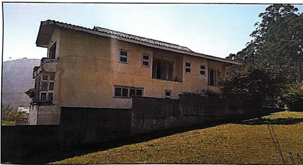
FOTO 09: FACHADA LATERAL ESQUERDA
