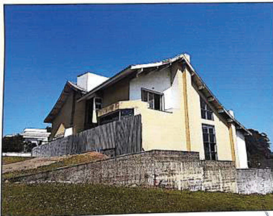
FOTO 07: FACHADA LATERAL DIREITA
