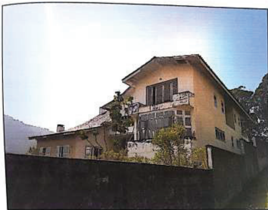
FOTO 12: FACHADA DOS FUNDOS
