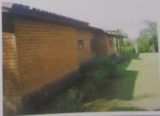
Figura 18 – Vista da residência principal.
