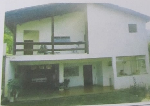
Figura 5 - Vista da casa de caseiro, com ênfase à garagem (piso inferior).
