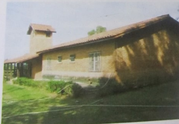
Figura 11 - Vista da residência principal
