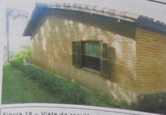
Figura 19 – Vista da residência principal.
