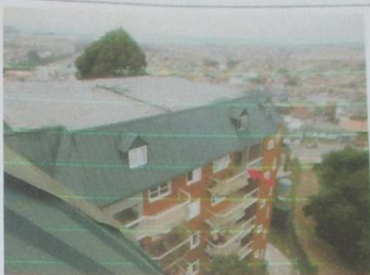
FOTO 4 – Vista do apartamento 42 – Bloco 1, objeto da avaliação.
