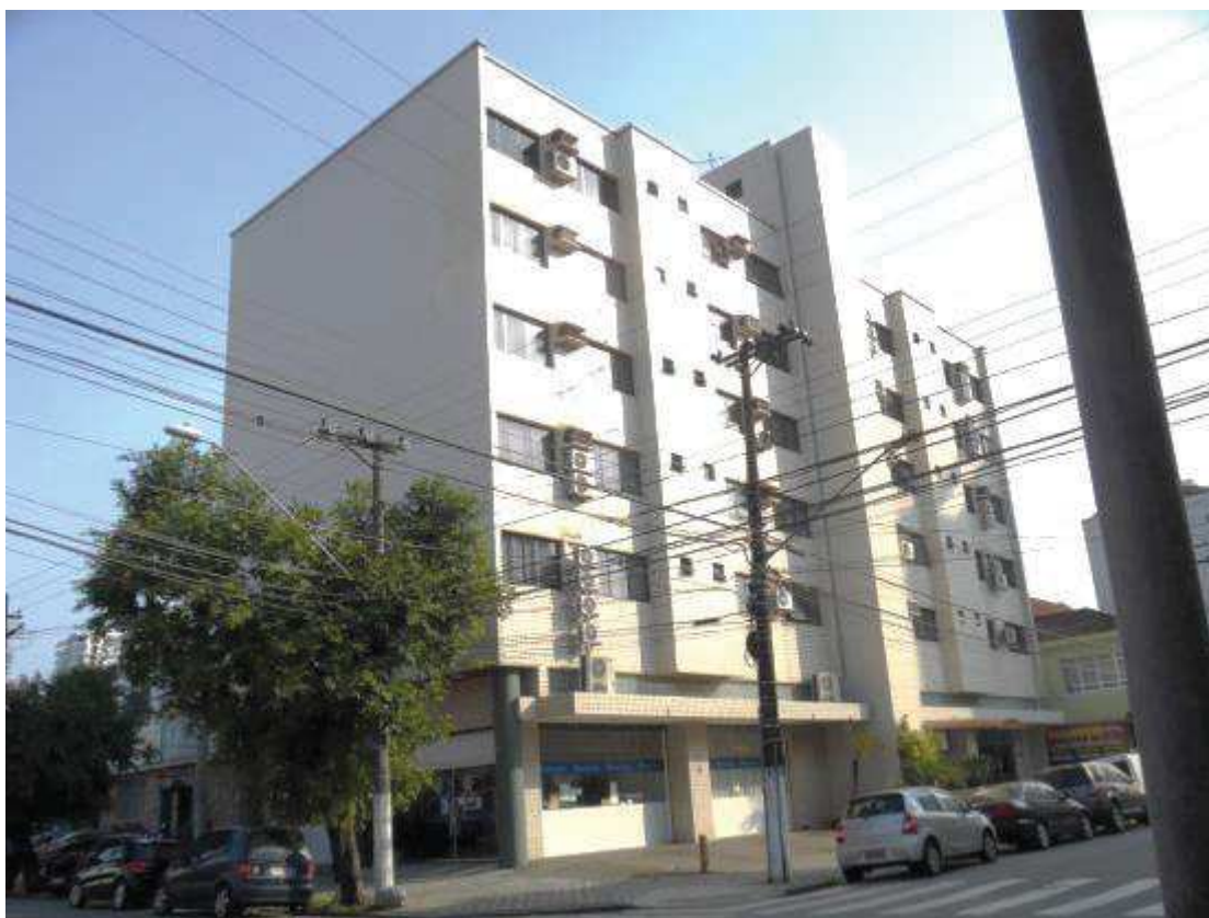
FOTO 01: Vista da fachada do imóvel.
