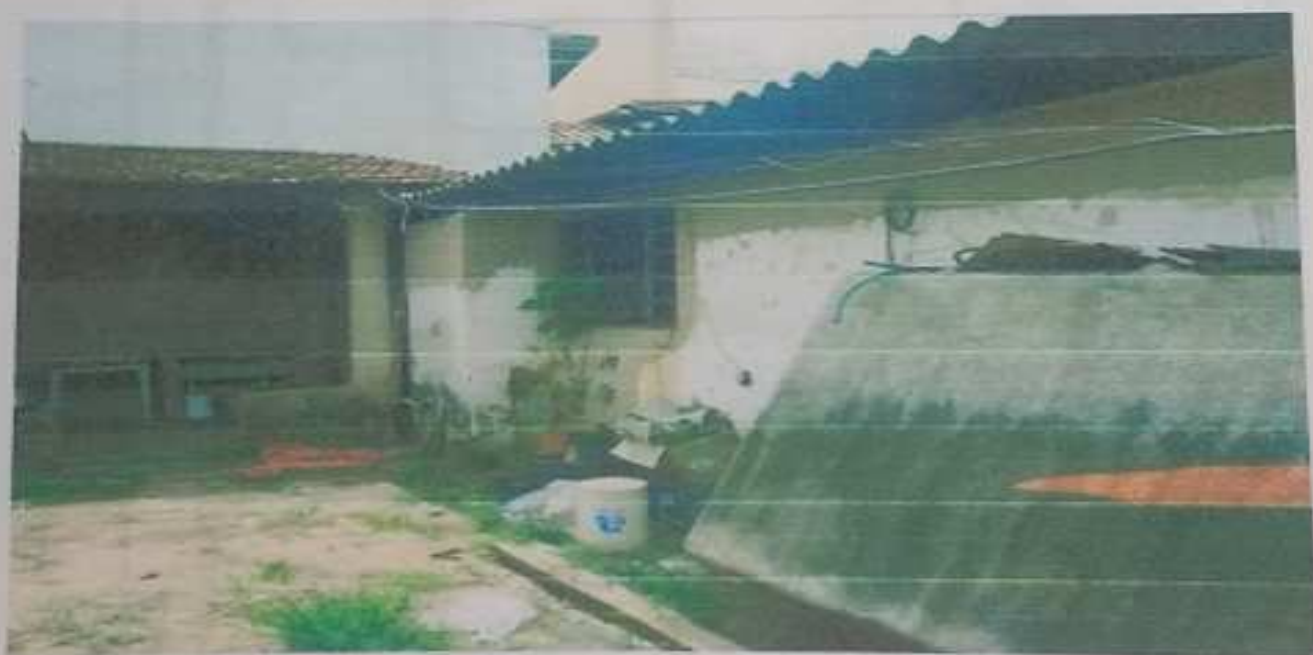
Imóvel avaliando – Vista dos fundos da Casa Residencial
