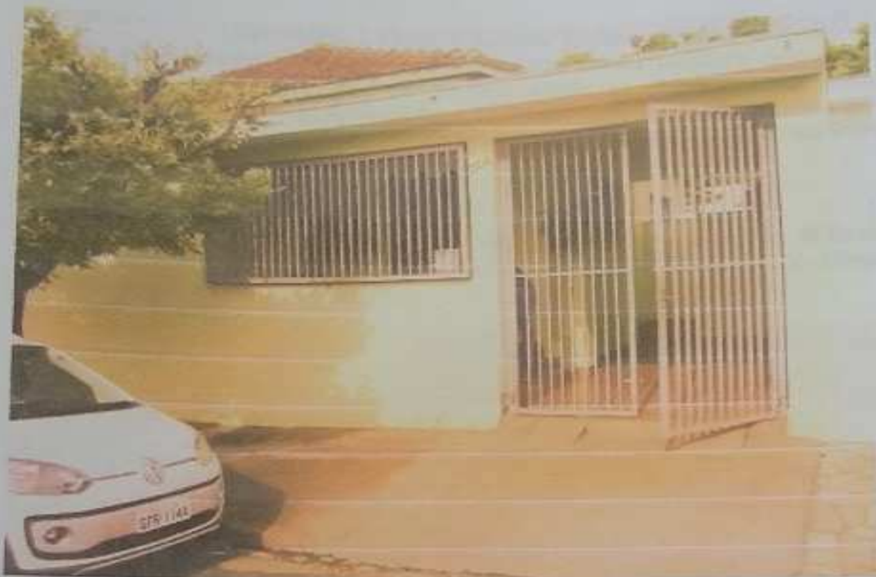
Imóvel avaliando – Corpo Principal - Vista Frontal da Casa Residencial
