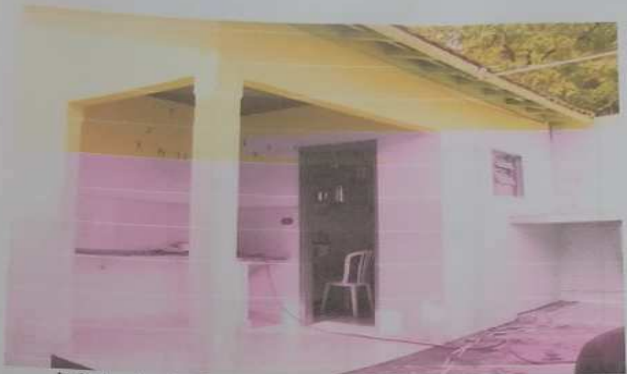
Imóvel avaliando – Corpo Secundário - Vista dos fundos da Casa Residencial
