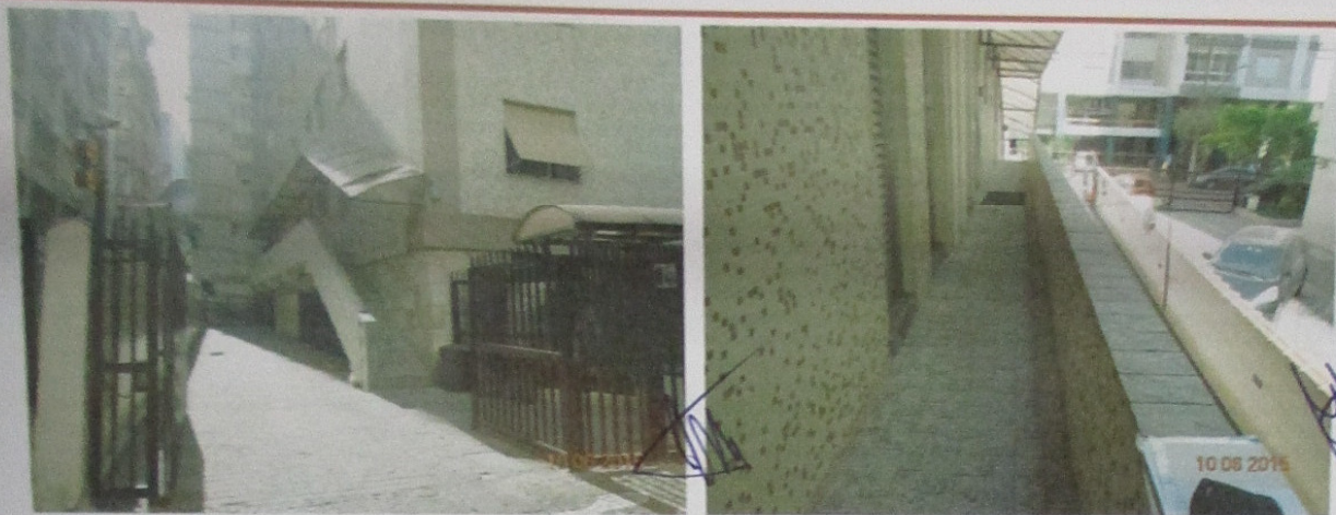
Vistas das escadarias de acesso de pessoas (à esquerda do prédio), a garagem do segundo pavimento, onde se localiza o imóvel avaliando.
