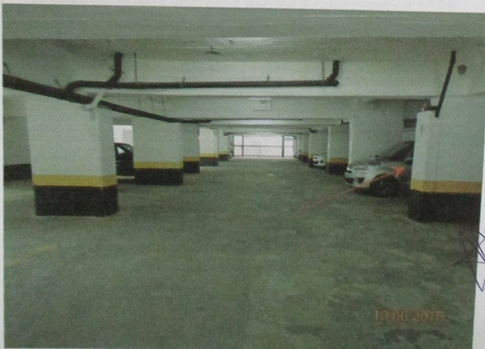
Vista da garagem do segundo pavimento, aos fundos a rampa de acesso de veículos. A seta vermelha aponta a garagem/box nº 26.
