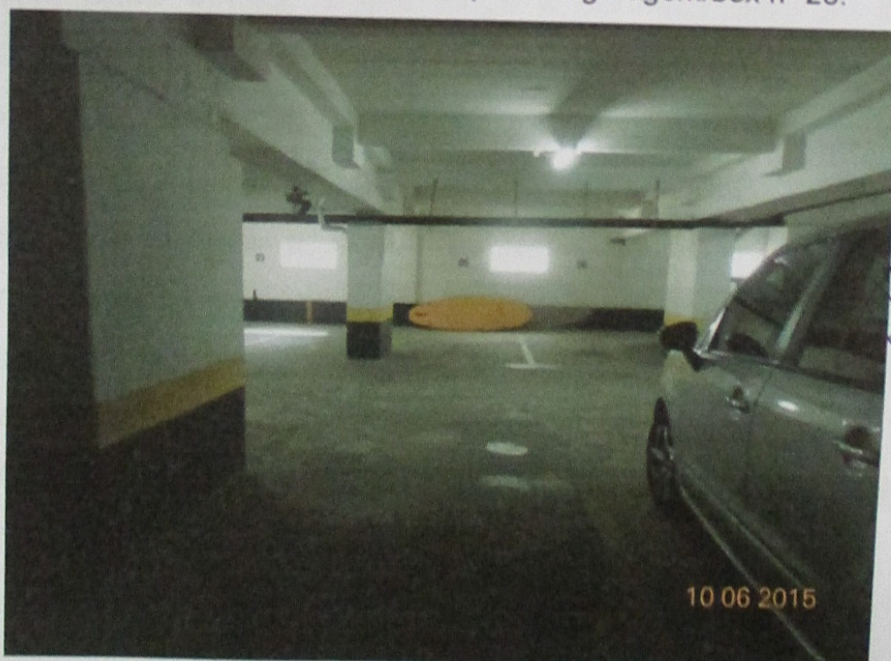
Vista da garagem/box nº 26, olhando para a frente, onde se localizam as vagas de nº 05 e 06.
