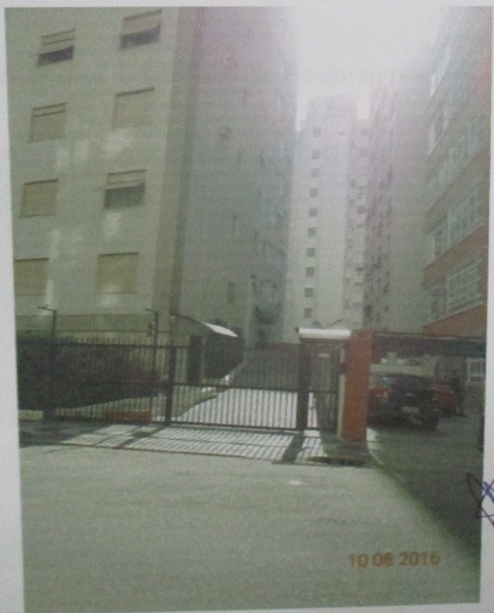
Vistas do acesso de veículos para a garagem do segundo pavimento (à direita do prédio).
