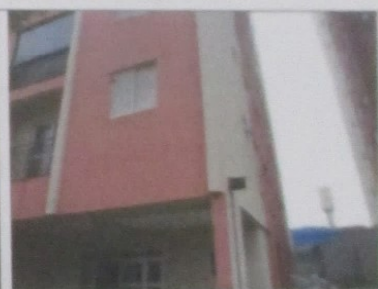
LATERAL DO APTO 12 BLOCO B
