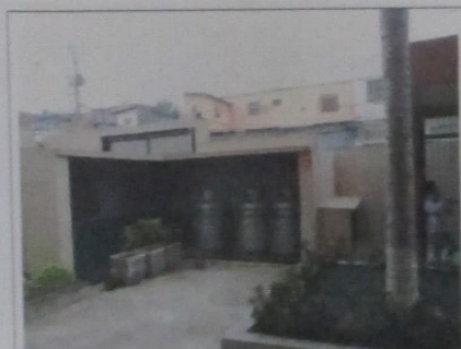
CENTRAL DE GÁS
