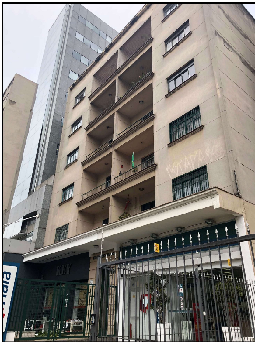
Foto 1: Fachada do Edifício Castro Prado
