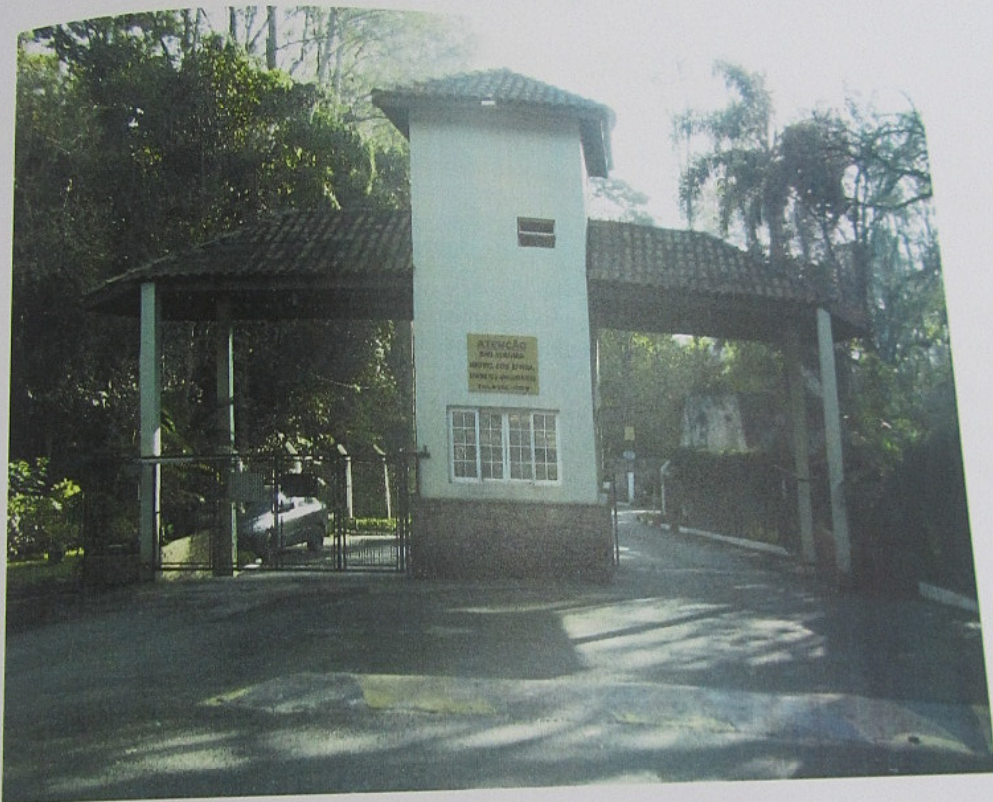
FOTO 10: SAÍDA DO LOTEAMENTO
