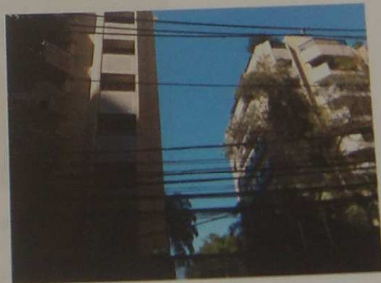
Foto 04 – Vista da torre do Edifício
