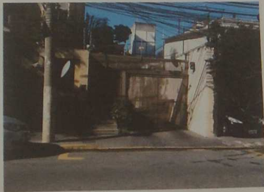
02 – Nova vista da entrada do Condomínio
