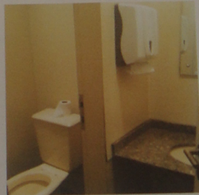
Foto 36 – Outra vista dos banheiros
