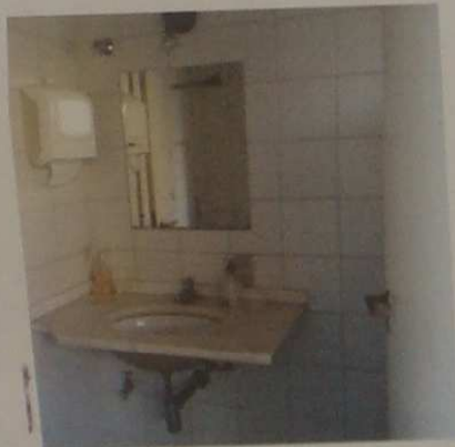
Foto 30 – Banheiro da Sauna
