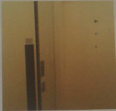
Foto 07 – Elevador acesso ao apartamento
