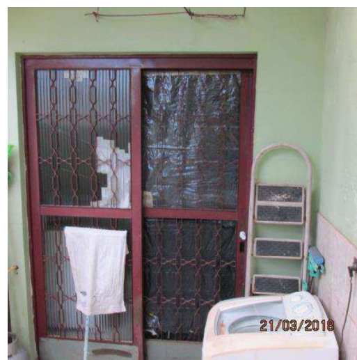
Foto 16. Ilustra porta da cozinha lado externo.
