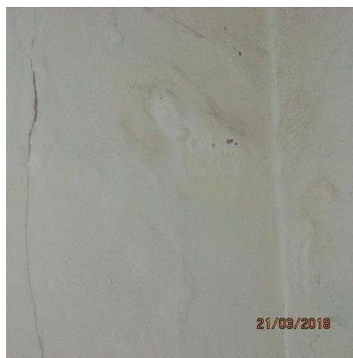
Fotos 11/12. Ilustram sala de TV, presença de umidade e fissura nas paredes.
