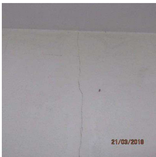
Fotos 11/12. Ilustram sala de TV, presença de umidade e fissura nas paredes.
