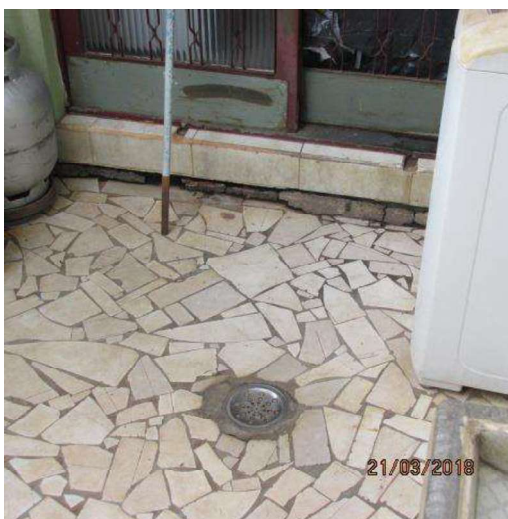
Fotos 25/26 ilustram lavanderia, piso cedendo, necessitando de reparos.
