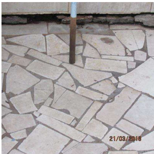
Foto 29.illustra Piso da lavanderia.
