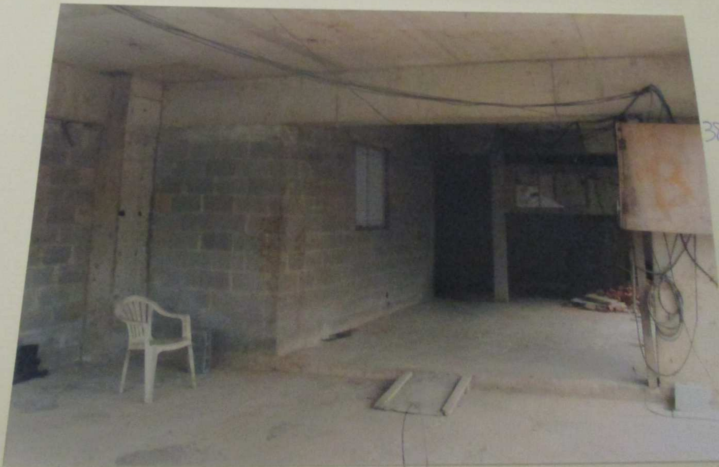
FOTO Nº 3 - Vista do térreo.
