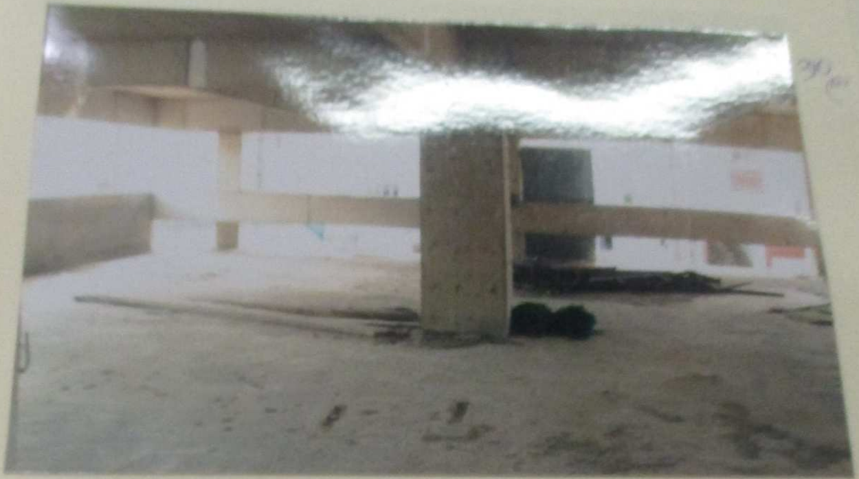
FOTOS Nº 4 e 5 - Vista da garagem no mezanino.
