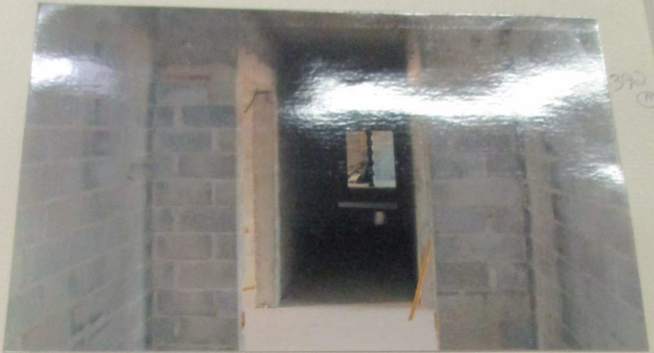
FOTO Nº 6 - Vista do corredor de distribuição do 13º andar.
