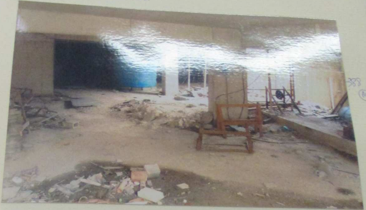
FOTO Nº 2 - Vista do sub-solo.
