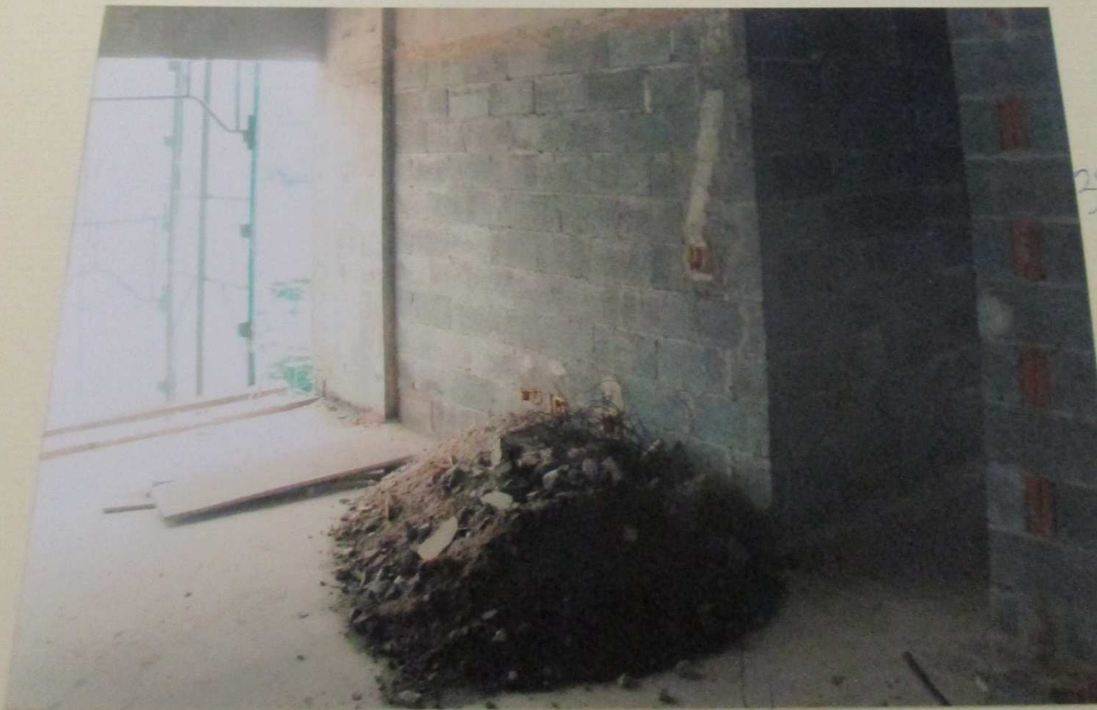
FOTO Nº 7 - Vista da sala da unidade 131.
