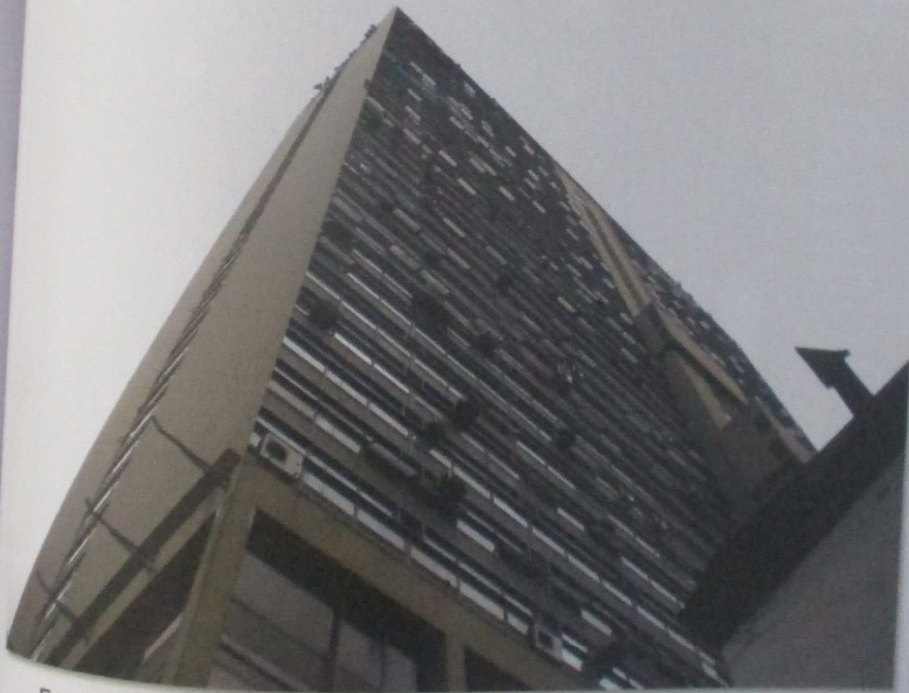
Foto nº 6 – Condomínio Edifício Mirante do Vale– vista frontal.
