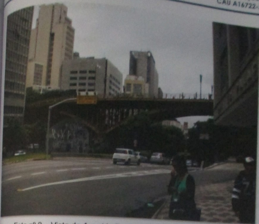
Foto nº 2 – Vista da Avenida Prestes Maia, nº 241 – lado direito.
