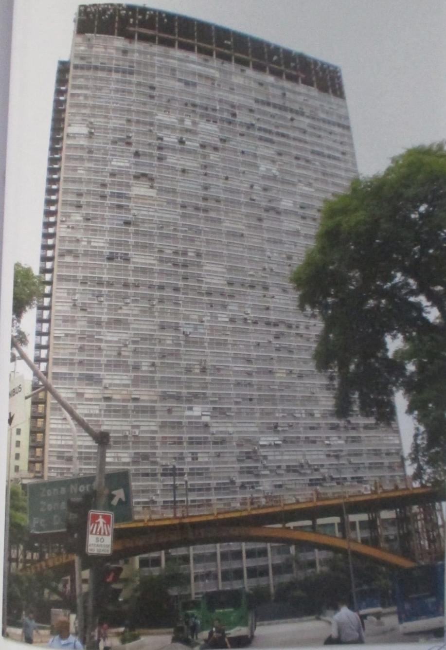
Foto nº 4 – Condomínio Edifício Mirante do Vale– vista frontal.
